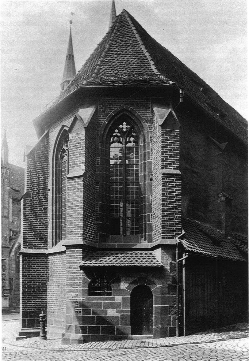
18 Der freigelegte Chor mit der neuen Sakristei. Sie diente auch als der behördlich vorgeschriebene Notausgang. Aufnahme 1912.
