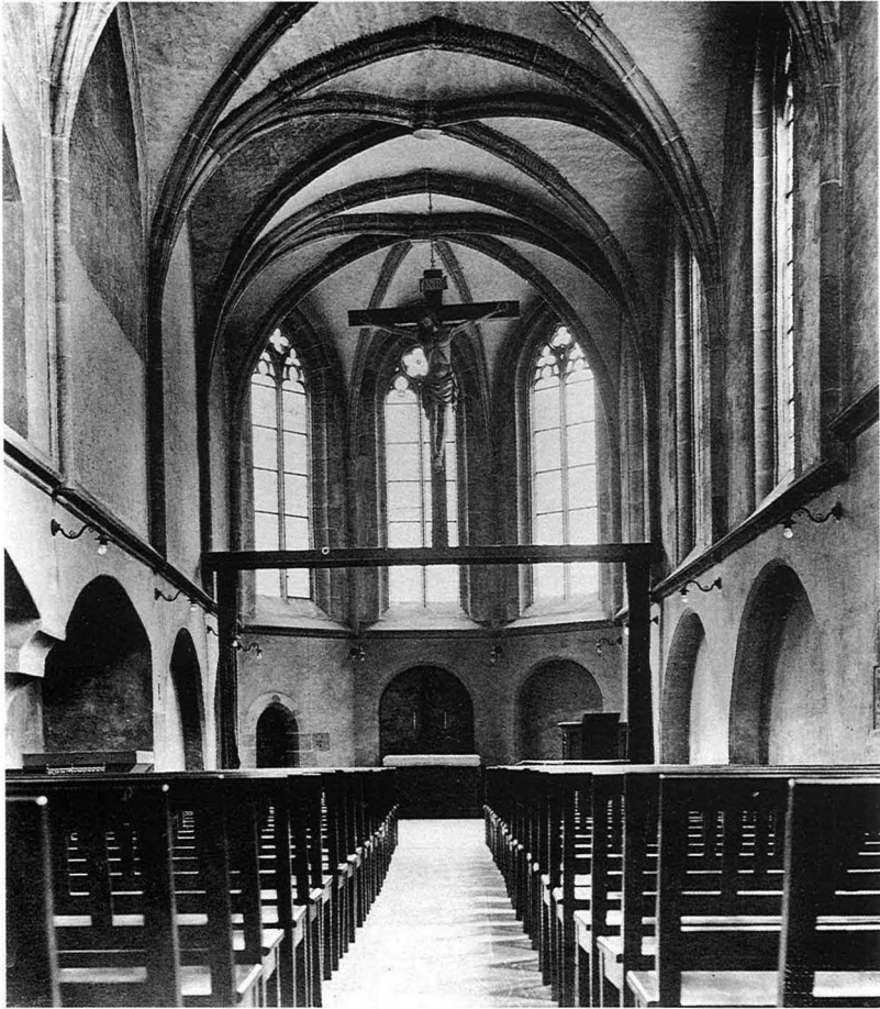
22 Das schlichte Innere 1935. Der Chor durch einen Vorhang abtrennbar. Links ist in der Nische der ehemalige Seitenaltar zu erkennen.
