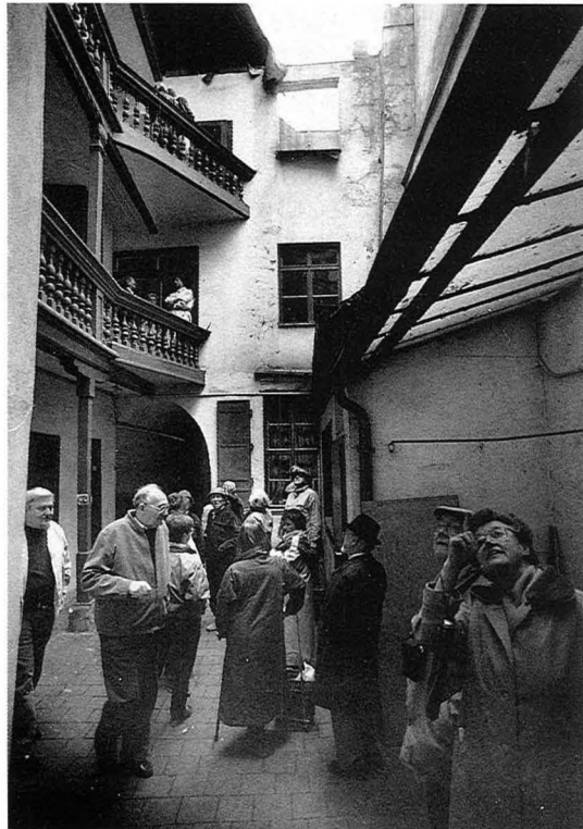
Auf dem ersten Entwurfs-Papier schon nicht mehr vorhanden: Barocke Hofanlage Winklerstraße 13 nach dem Rettungskauf (mit Besuchern in allen Stockwerken)
