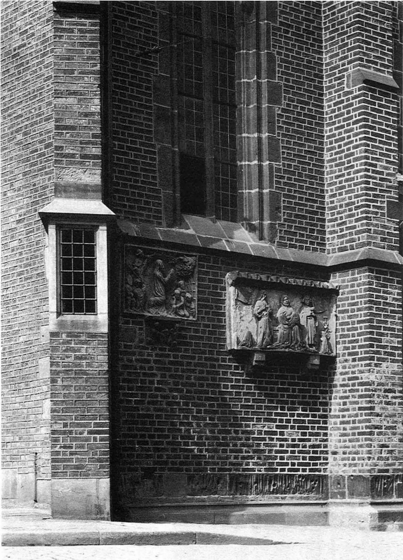
5 Lichtnische im südwestlichen Strebepfeiler. Mit vergitterten Öffnungen nach drei Seiten. – Am Kirchensockel zahlreiche Wetzrillen und Näpfe. Die Reliefs: Links Ölberg, rechts Anna selbdritt zwischen beiden Johannes; 14. bzw. 15. Jahrhundert. Aufnahme um 1912.
