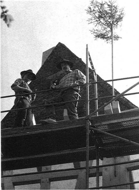
Klein-Richtfest statt Groß-Sanierung: Baum und Zimmermanns- spruch im Hinterhof Bergstraße 23
