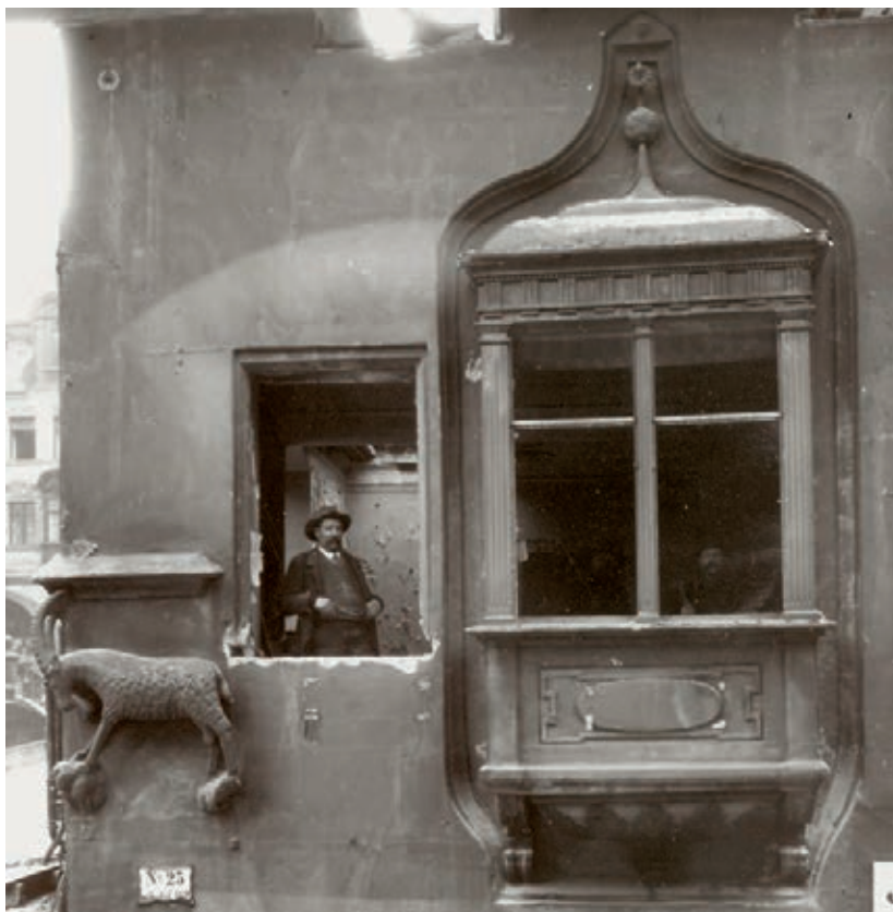
27 Ein letzter Blick auf das schöne Chörlein (um 1911). Der Abbruch hat begonnen. Fenster und Bleche sind ausgebaut, das Tageslicht scheint von innen durch die hohlen Fensteröffnungen des alten Hauses. Nur der Steinbock wird gerettet.
