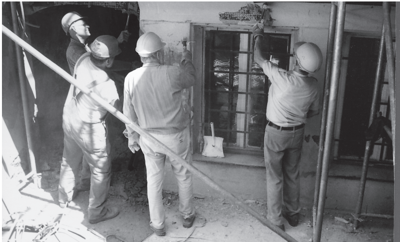
18 Schutträumen im Haus Pfeifergasse 9
