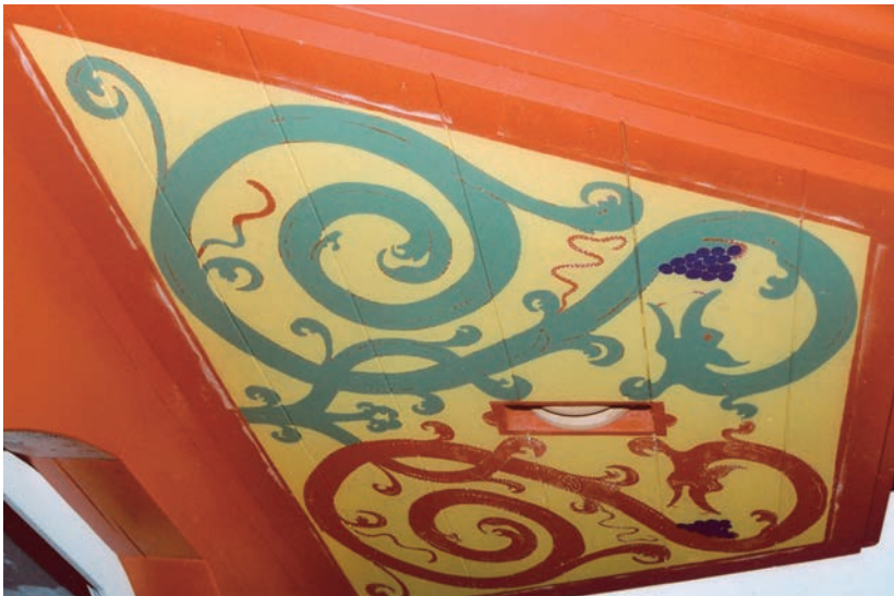
7 Weißgerbergasse 29, Unterseite Dacherker
