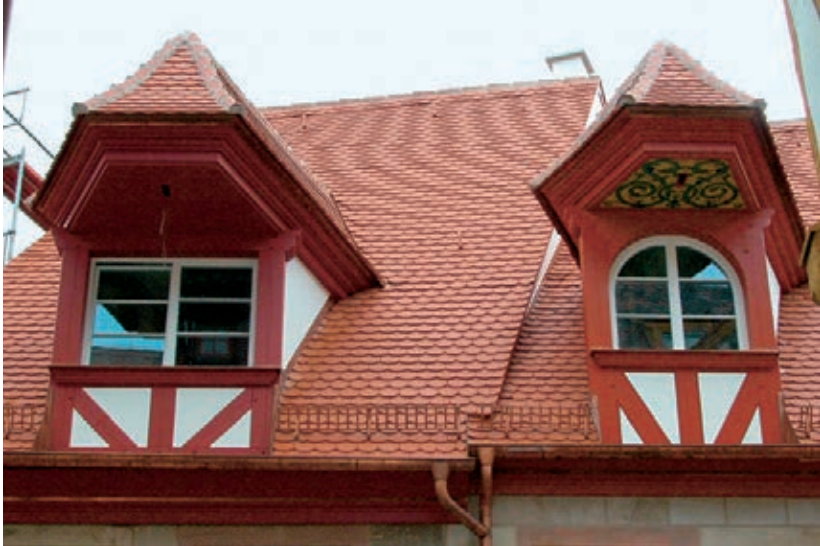
6 Weißgerbergasse 27/29, Dacherker auf dem Doppelhaus
