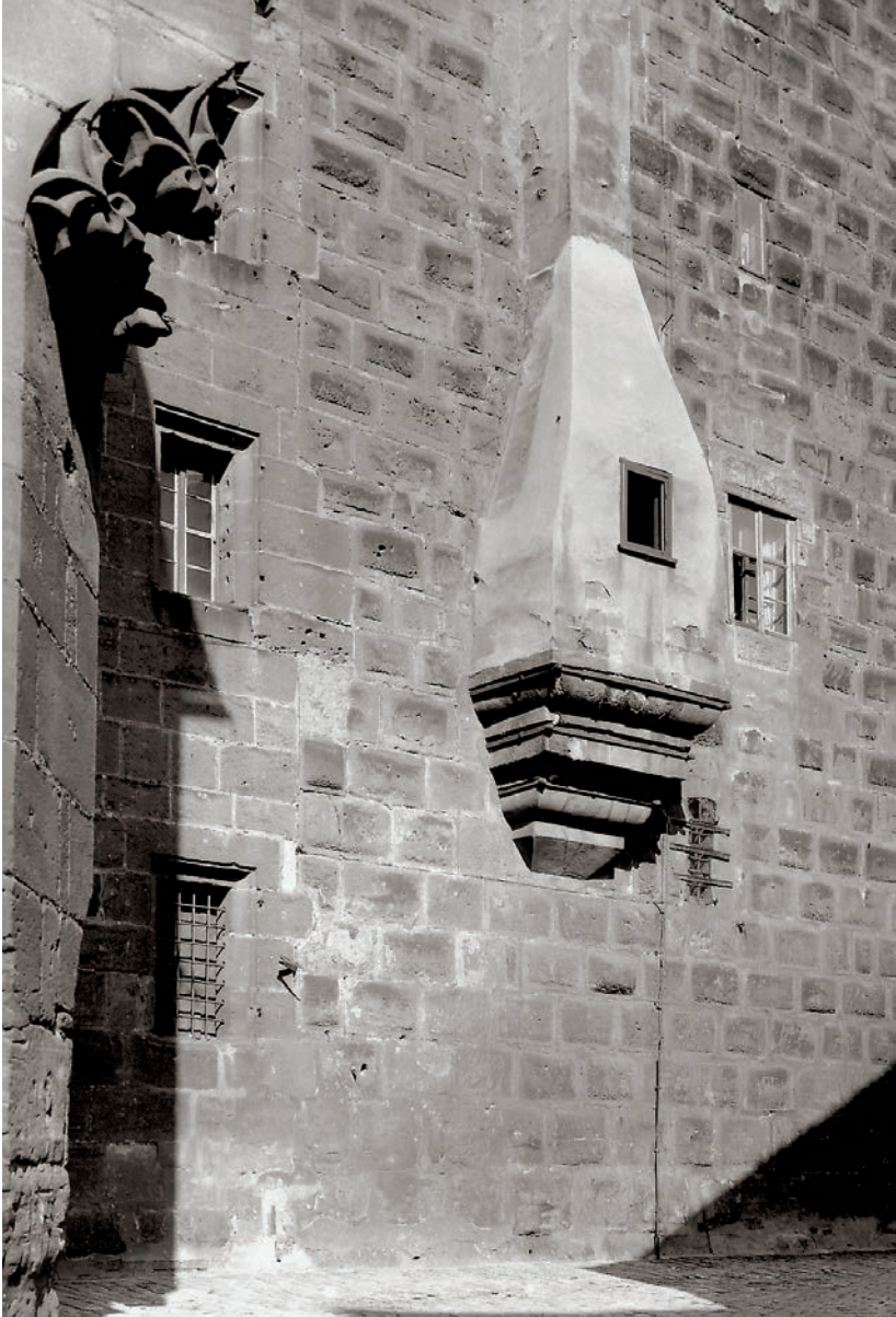
7 Der auskragende Anbau mit Schlot 1936.
