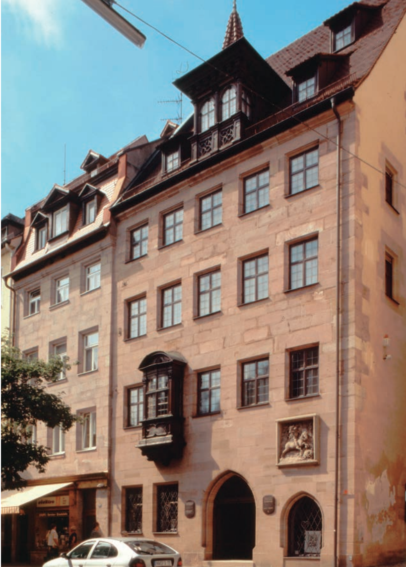
8 Mit Steildach und Erker wieder komplett. Im Erdgeschoß das neue Hauszeichen. Beim Nachbarn allerdings historischer Kahlschlag: Die profilierten Barockfensterbänke sind verschwunden.
