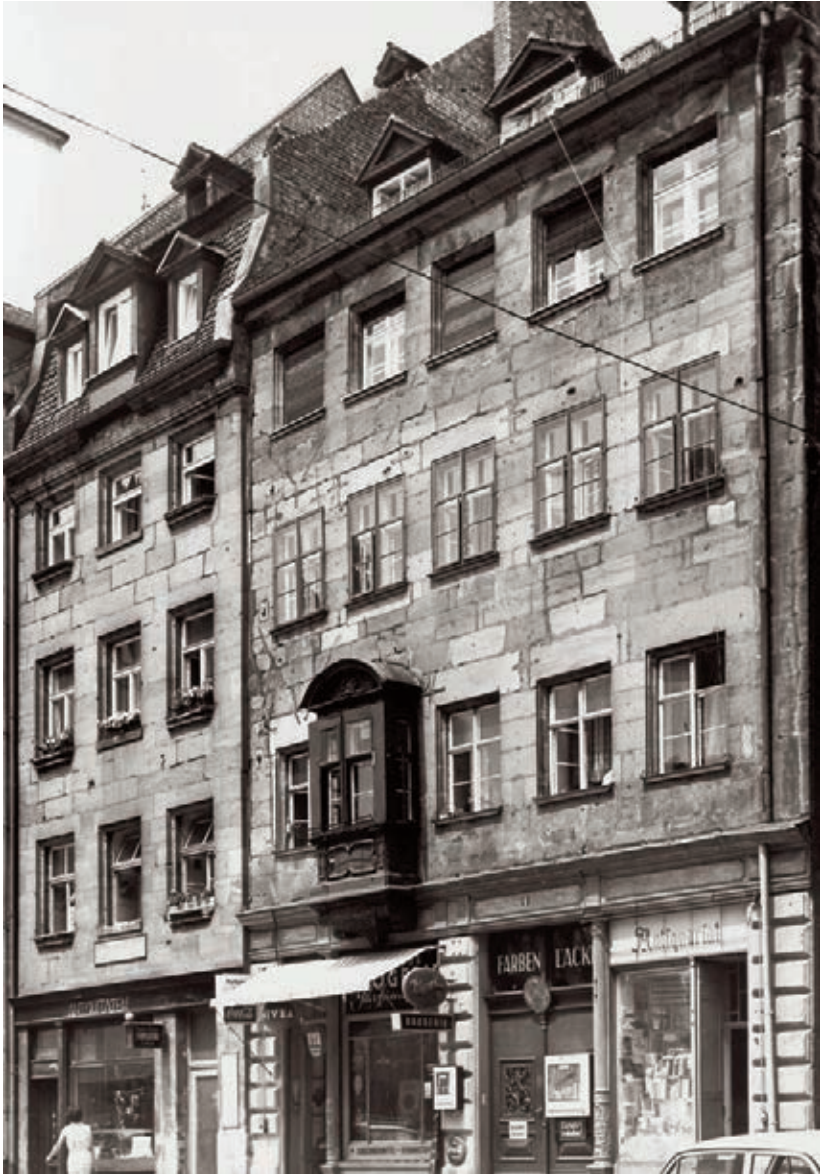
7 Heute schon ein ungewohntes Bild: Weinmarkt 6 vor 1977 mit Notdach und gründerzeitlichem Ladeneinbau.
