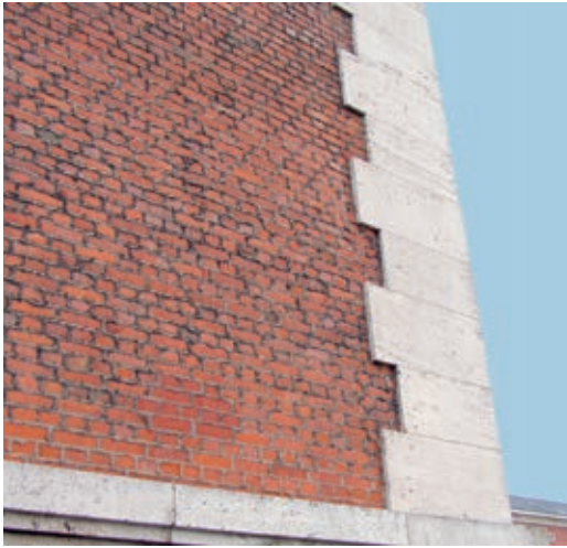
23 (links) Eckquaderung an der Südkaserne mit sehr groben Bandfugen.
