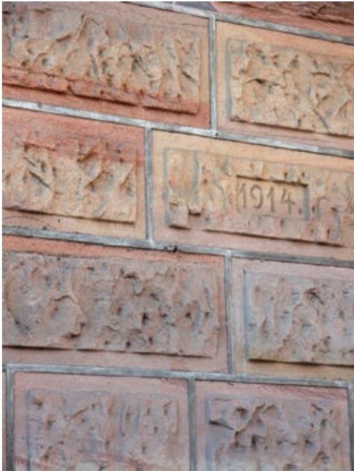
18 Mit Rand und Band – Sandsteinquader am Erdgeschoss es Gebäudes Kaulbachplatz 5 in der Nürnberger Nordstadt.
