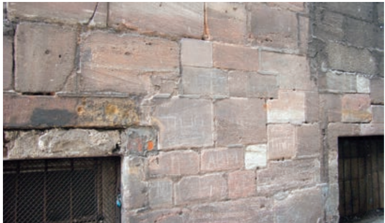
16 Altes Mauerwerk mit neuen (Band-) Fugen – Adlerstraße 36 in Nürnberg.
