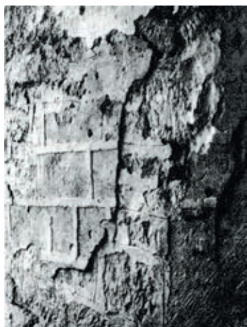
10 Neuenburg bei Freyburg/Unstrut (Landkreis Naumburg), Nordwand des Abortgangs – Erstfassung mit Fugenstrich und Ritzung. Wohl um die Mitte des 13. Jahrhunderts wurde darauf ein rötlich durchgefärbter Lagenputz mit aufgelegten Fugen angebracht.
