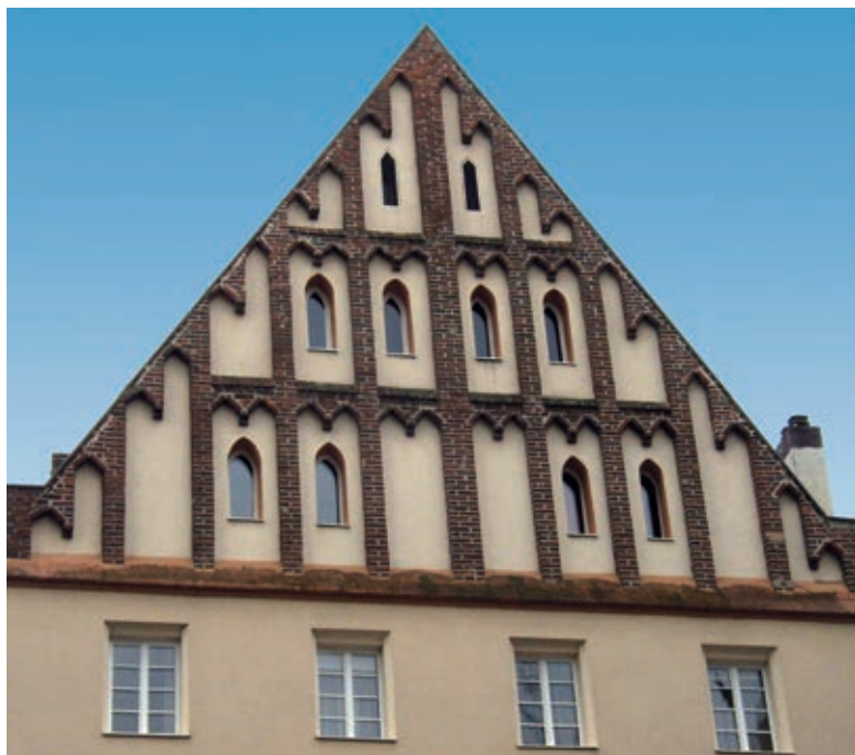
1 Spätmittelalterliche Backsteinarchitektur in Nürnberg – Blendbögen aus Ziegelmauerwerk am Haus Weinmarkt 2.
