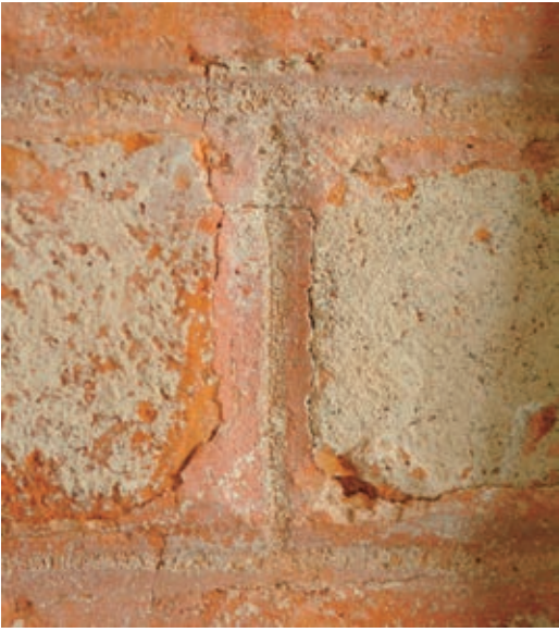
12 Gerundet, gestrichen, geritzt – Fugengestaltung an der Ulanenkaserne in Bamberg, 1863.
