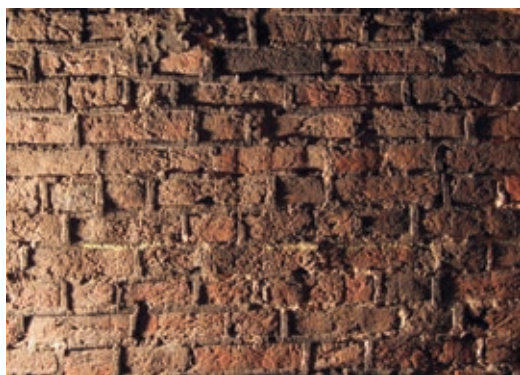
8 Eine der besterhaltenen Wandflächen mit Originalbefunden plastischer Fugen des späten Mittelalters in Nürnberg – Rückgebäude des Hauses Füll 8 (= Agnesgasse 7).
