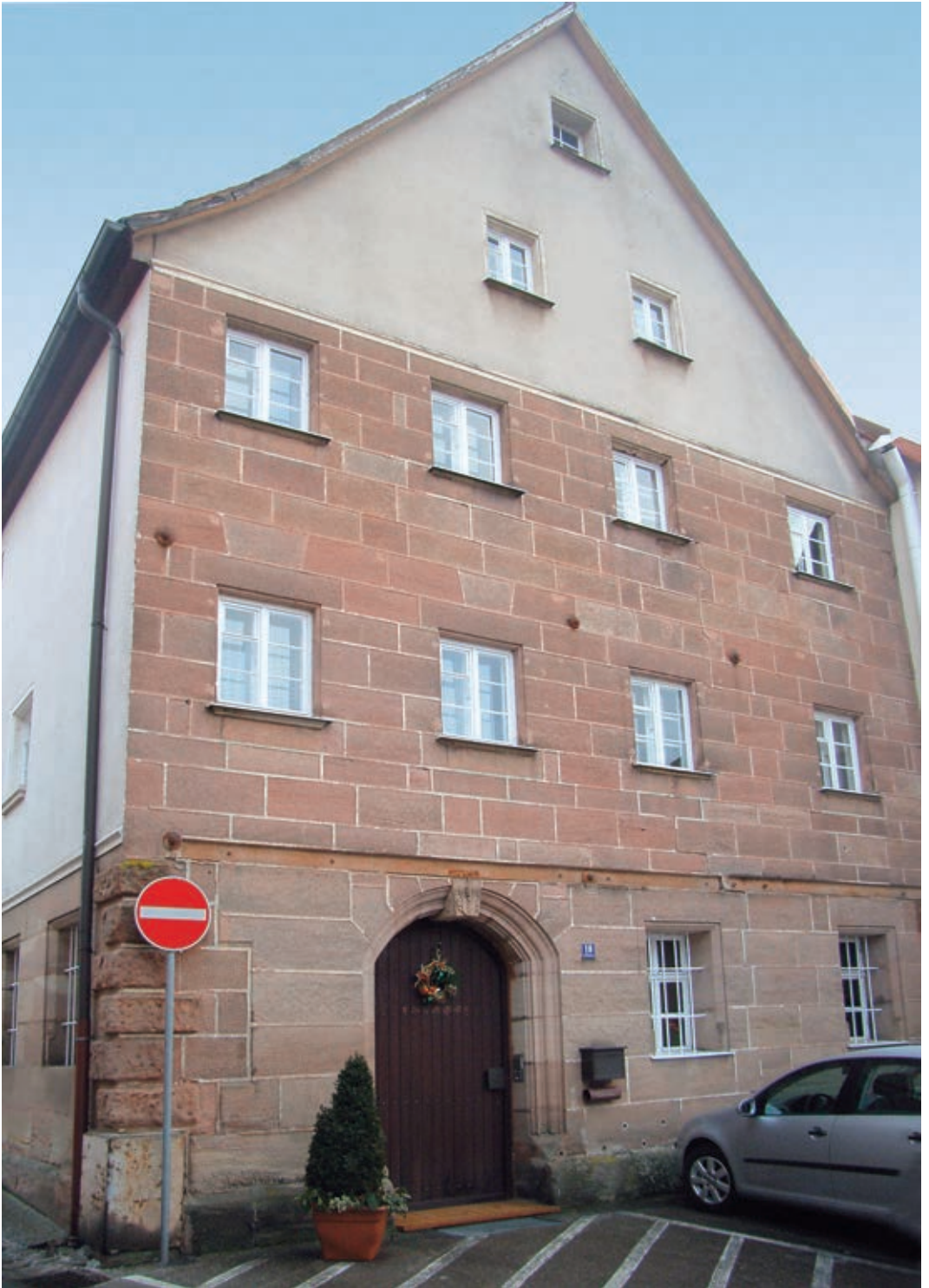
14 Hammerwerk in Nürnberg-Katzwang – Die gesamte Sandsteinquaderfassade ist mit dem plastischen Fugenwerk überzogen.
