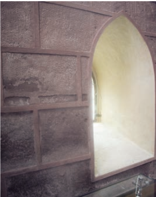
13 1895 angebrachte Bandfugen im Inneren der Bad Windsheimer Spitalkirche. Die Oberflächen der spätmittelalterlichen Sandsteinquader wurden neu bearbeitet, das mit aufgesetzten Fugen gerahmte spitzbogige Fenster als „gotisierende“ Zutat ins Mauerwerk eingefügt.
