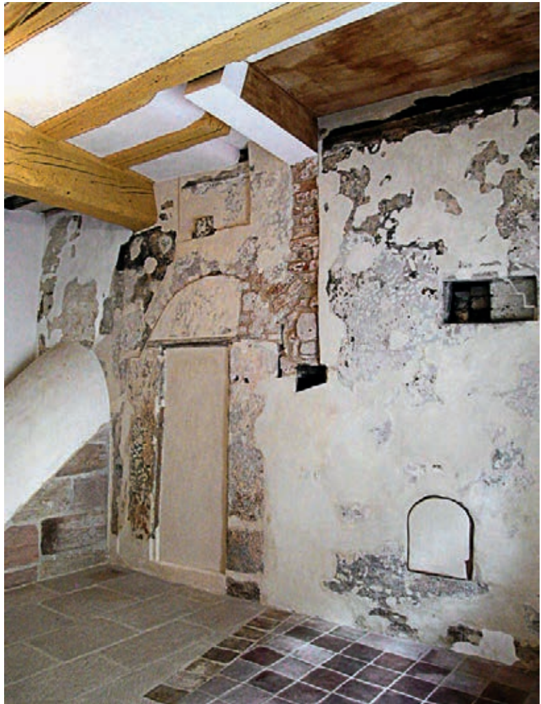
45 Heiz- und Küchenraum des ehemaligen Bades
