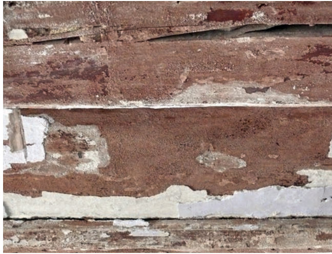
29 Reste gesandete Farbfassungen in einem Bauernhaus in Großreuth hinter der Veste
