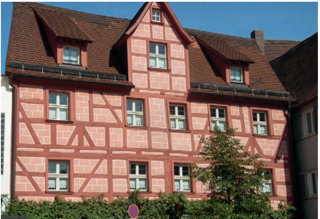
7 Am 1665 erbauten Haus Eisenhüttlein 7 in Hersbruck sind bauzeitlich in den Gefachen Quader aufgemalt gewesen. Die Rekonstruktion (Holger Wilcke) erfolgte vor wenigen Jahren.
