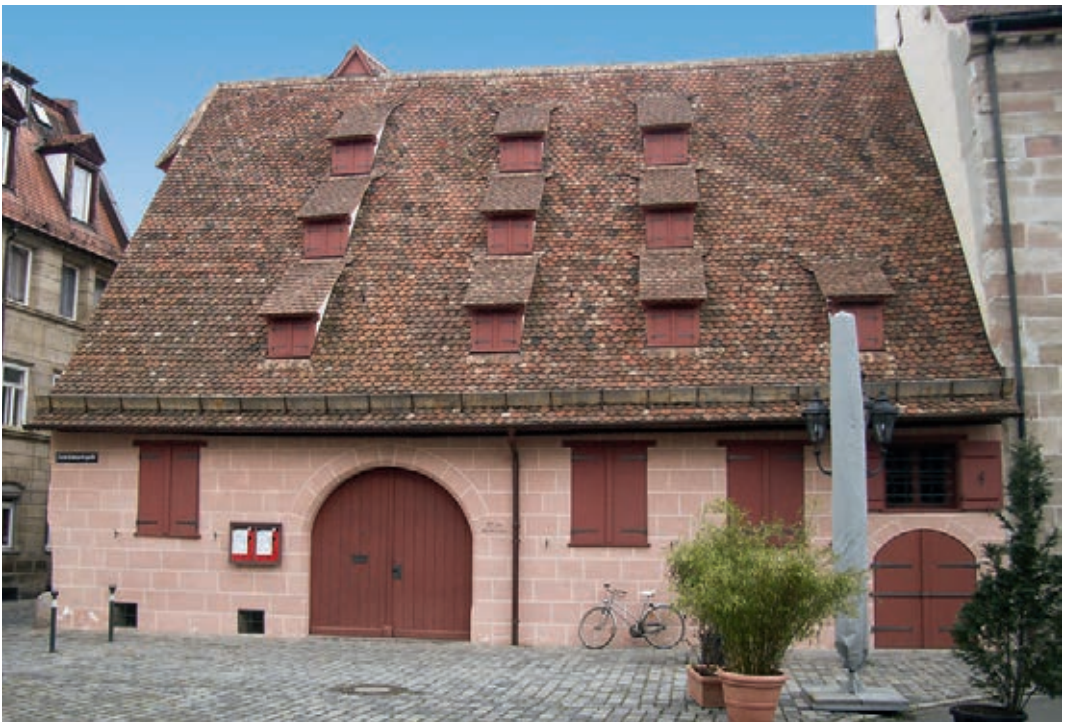
4 Rekonstruierte Quadermalerei des späten 17. Jahrhunderts an der Scheune in der Zirkelschmiedsgasse
