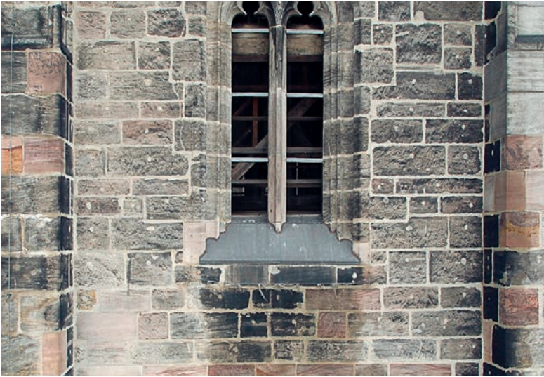
14 Nürnberg, St. Sebald, Südturm, Südfassade
