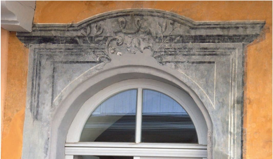
23 Letzte Reste einer Scheinarchitektur um die Fenster an einem ehemals vor den Toren der Stadt gelegenen Palais (Johannisstr. 13)
