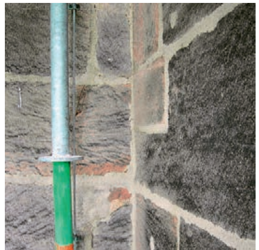
15 Nürnberg, St. Sebald, Nordturm, Nordfassade, 3. Turmobergeschoss, rechts der im Zuge der Turmaufstockung 1483 erhöhte Strebepfeiler
