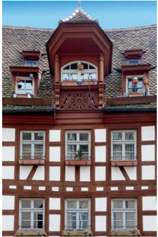
73 Die Krönung: der neue Aufzugserker mit dem gotischen Maßwerk in der Brüstung
