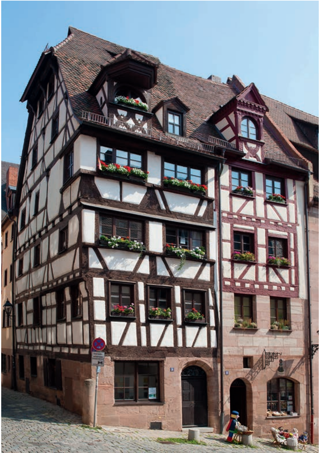
82 Das gewaltige Eckhaus verriet sein wahres Alter erst während der Sanierung.
