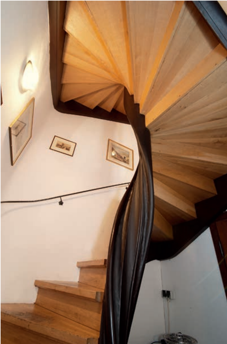
16 Die restaurierte Spindeltreppe führt in das 1. OG.
