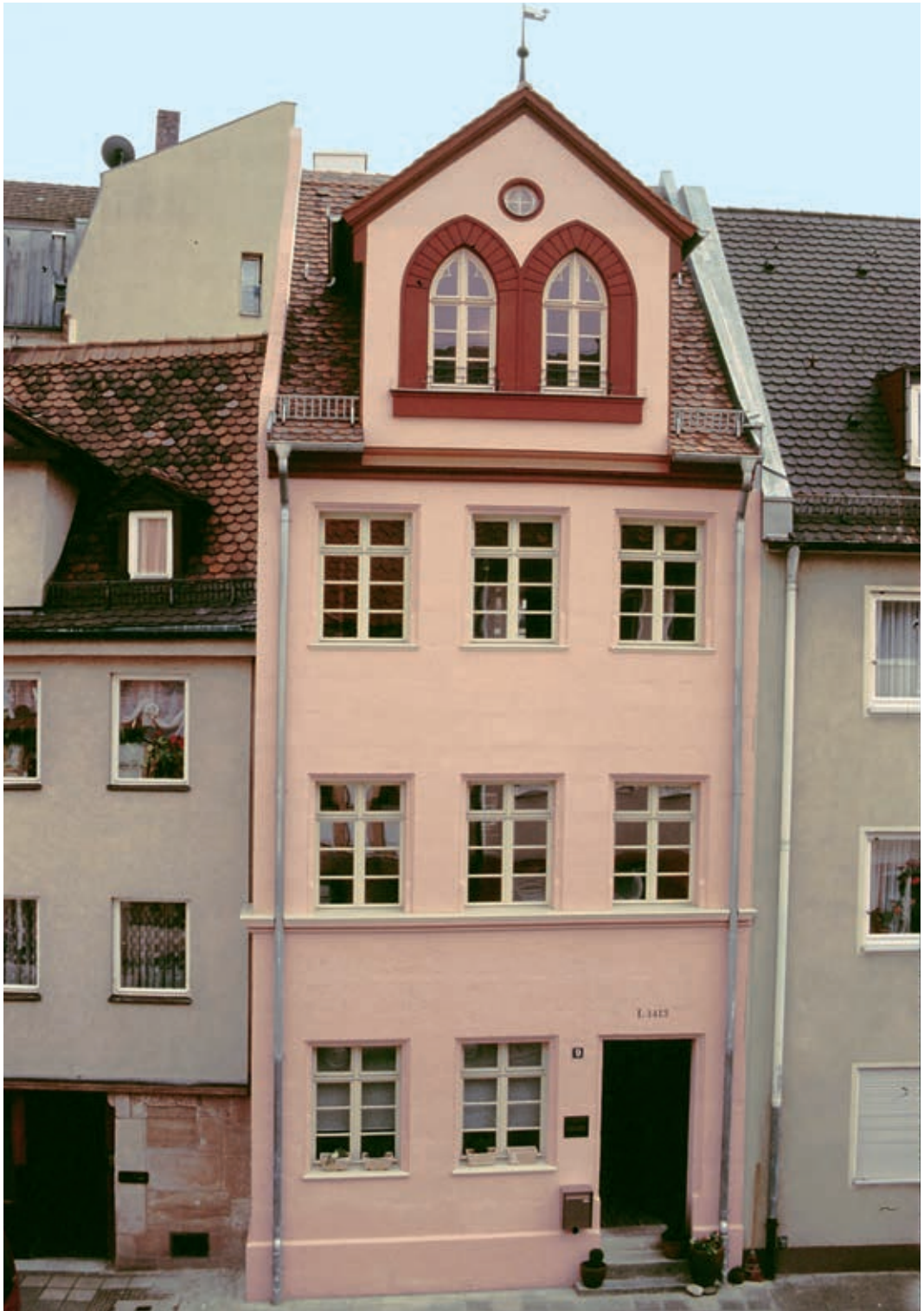
41 Die Straßenfassade nach der Renovierung mit dem auffälligen neugotischen Dachkerker
