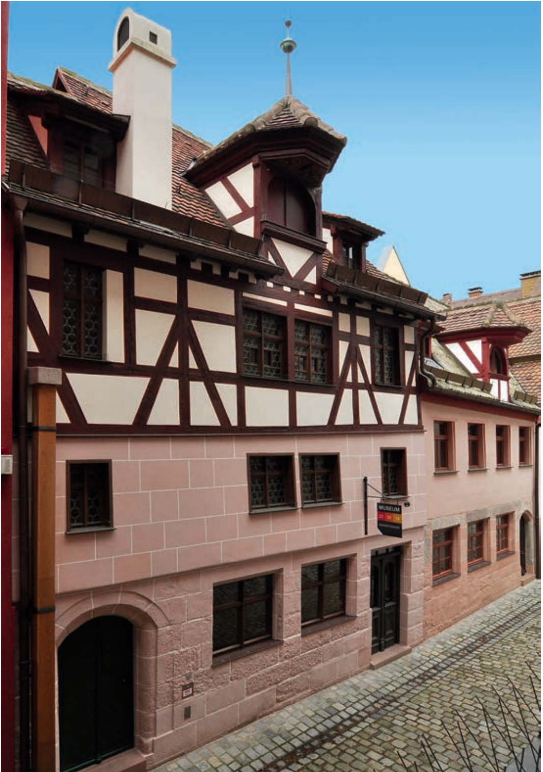
35 Das Fachwerk am größten und ältesten Haus des Ensembles macht die Erweiterung von 1700 deutlich.
