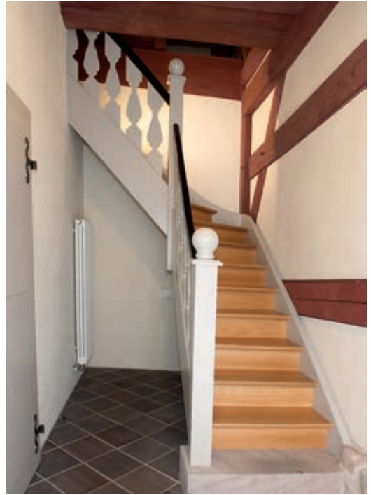
93 ... und nach der Restaurierung.
