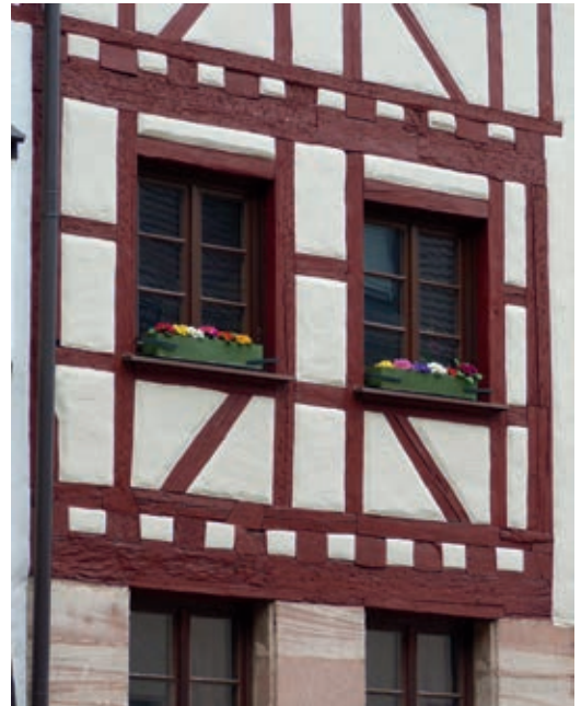
78 ... die einfache Fachwerkkonstruktion
