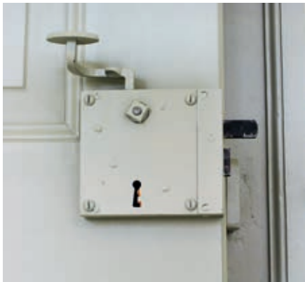
45 Alle Türen erhielten passende Kastenschlösser.
