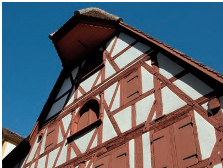
98 Der bereits 1986 freigelegte Fachwerk- giebel mit dem rekon- struierten Aufzugswalm und auffallendem Strebenfachwerk
