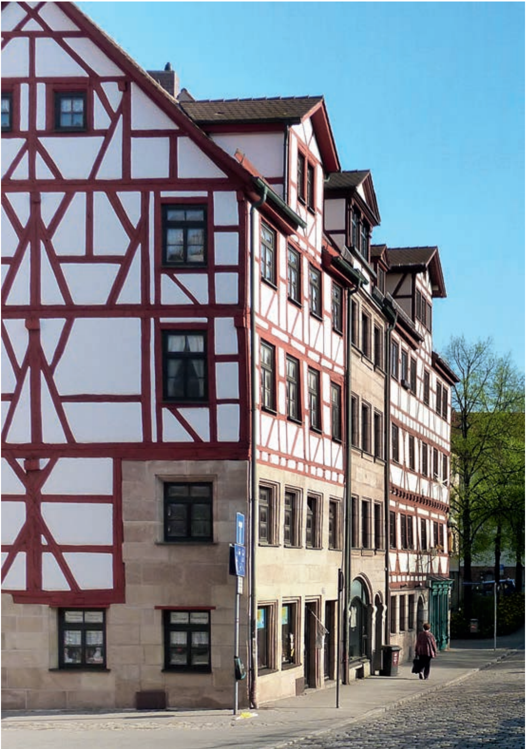
1 Heute tragen die sanierten Häuser auf der Westseite des Unschlittplatzes wesentlich zum Flair eines der schönsten Plätze Nürnbergs bei.
