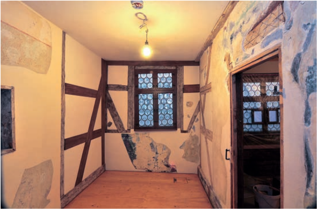
38 Zahlreiche Befundfenster an den Wänden zeigen den Besuchern die unterschiedlichen Wandbemalungen im Laufe der Zeit.
