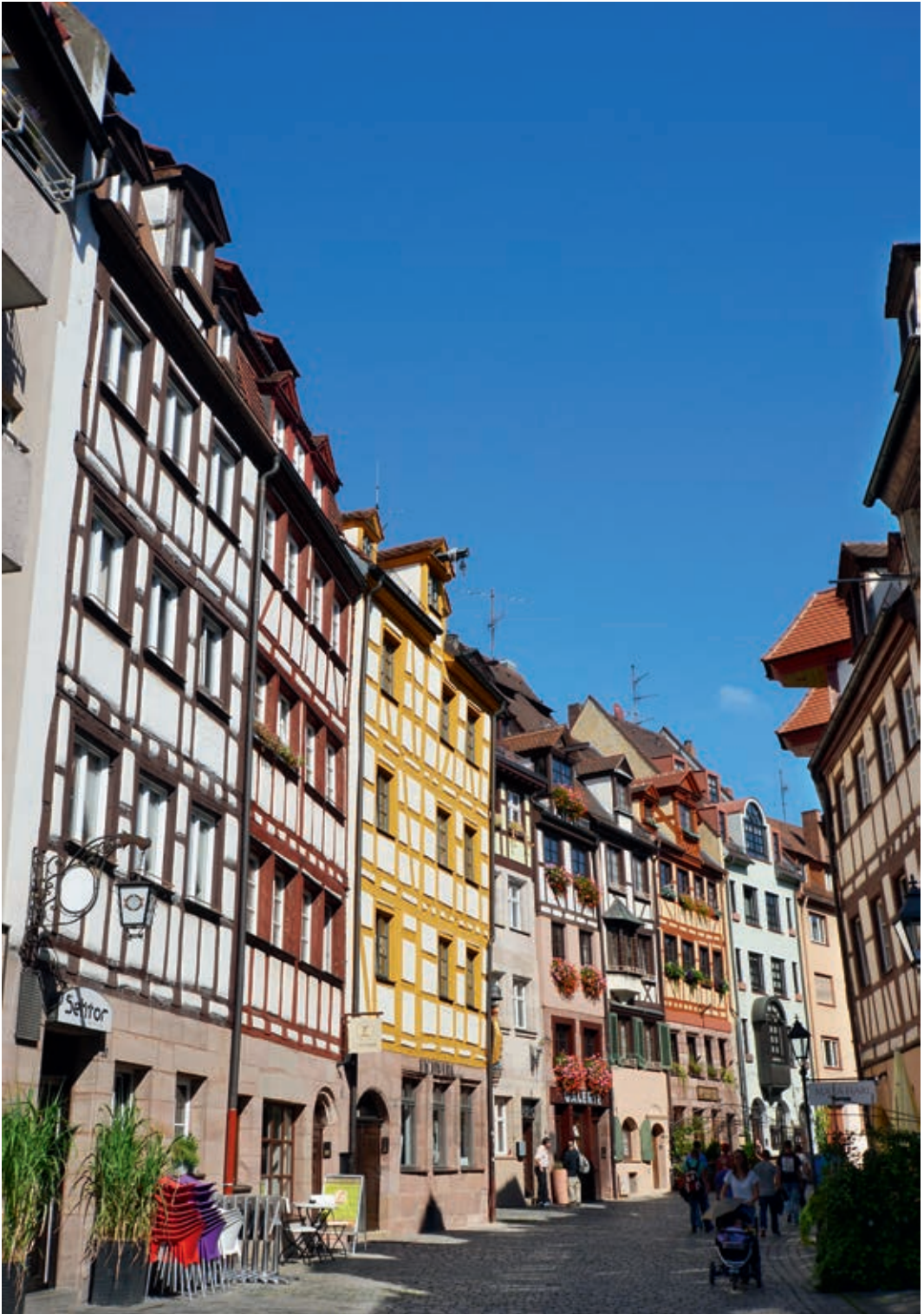
2 In der Weißgerbergasse trugen die Altstadtfreunde durch Fachwerkreilegungen in hohem Maße zur Wiederherstellung einer typischen Nürnberger Altstadtgasse bei.
