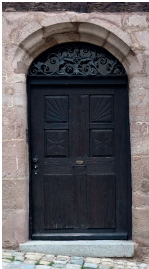
86 Eine typische Vierfeldertür mit Oberlichtgitter
