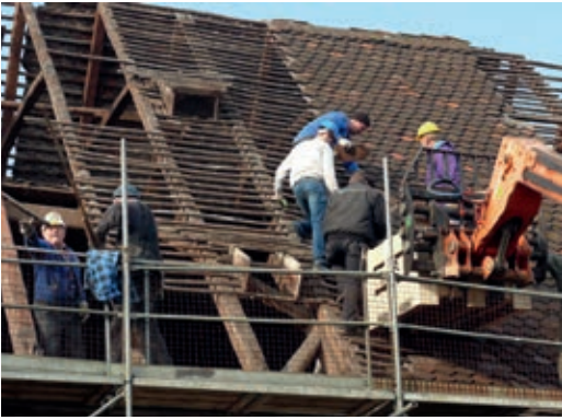
4 Die Baugruppe beim Abdecken eines Stadels in Zirndorf
