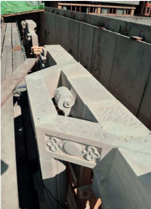
6 Blick von oben in das Chörlein. Obwohl später nur unvollständig sichtbar, ist auch hier der Schlussstein voll ausgeführt.
