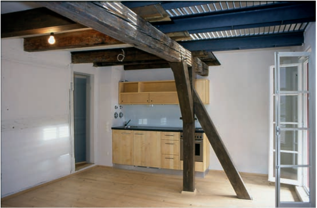
58 Originale Holzbalken und moderne Stahlträger sind für die Statik des Hauses notwendig und haben im Zusammenspiel durchaus ihren Reiz.
