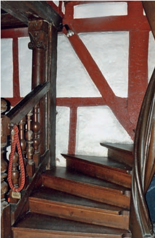
80 Der besonders schöne Handlauf konnte restauriert und erhalten werden, die Stufen wurden erneuert.
