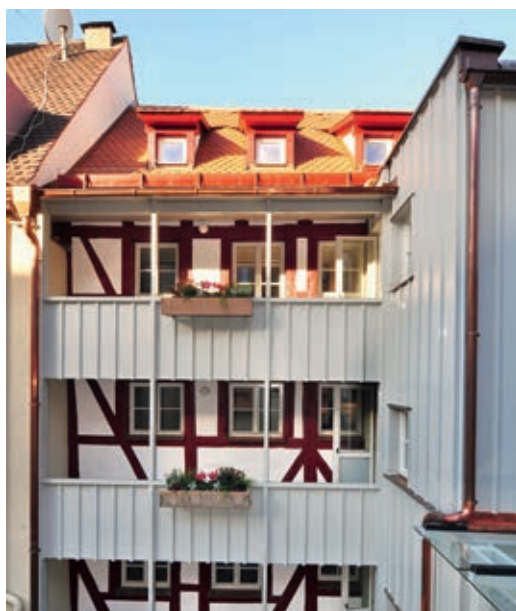
63 Das vornehm zurückhaltende Grau der neuen Gebäudeteile und das kräftige Rot des historischen Fachwerks ergeben ein harmonisches Bild.
