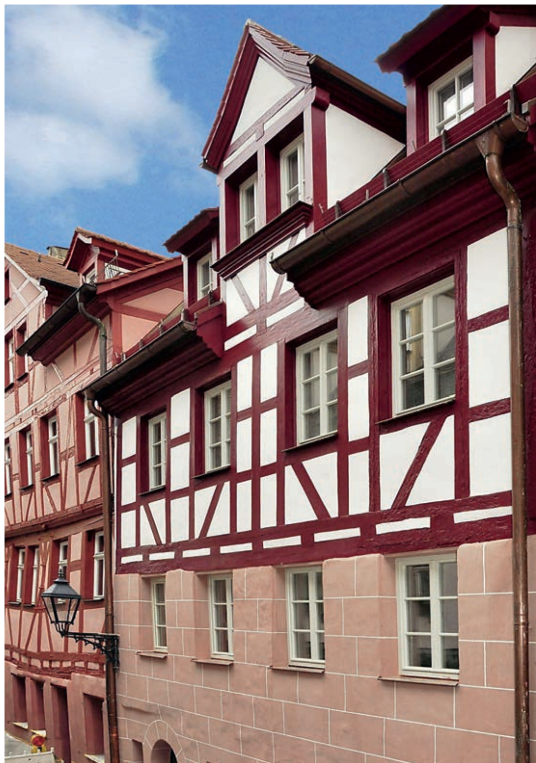
61 Quadermalerei und Fachwerksichtigkeit kennzeichnen die Straßenfassade.
