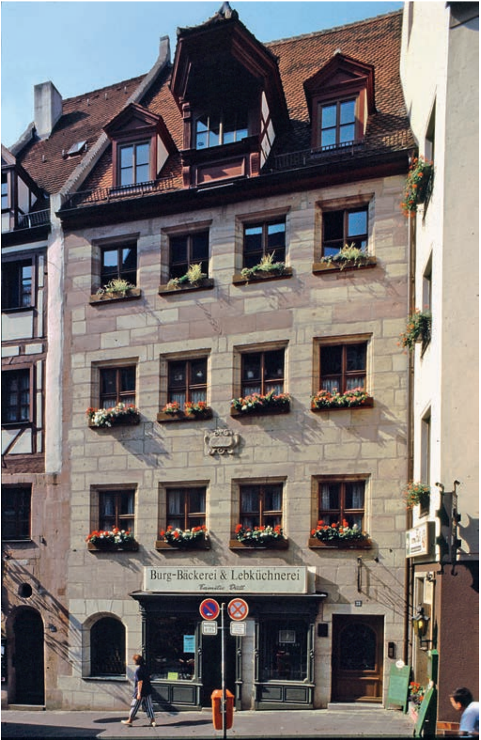
8 Nach der Restaurierung erstrahlt die Fassade in ihrem ursprünglichen Erscheinungsbild.
