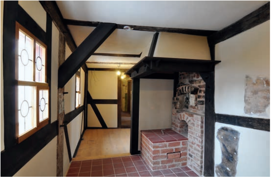
32 Die rekonstruierte Feuerstelle in der Dielenküche im 1. OG mit Schürloch für den Hinterladerkachelofen in der Mittelalterstube
