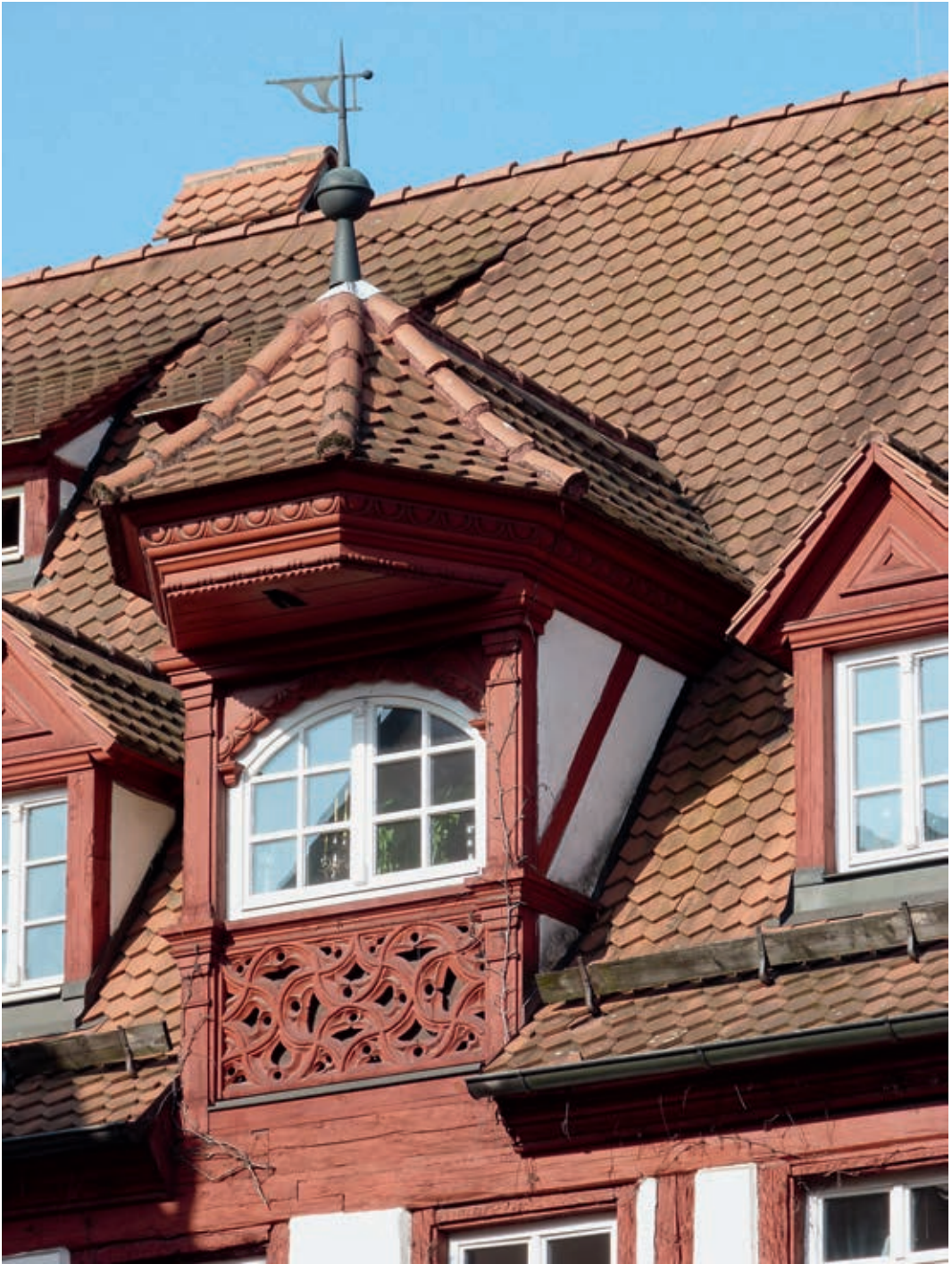
1 Das Brüstungsfeld des Aufzugserkers in der Kappengasse 16 ist besonders kunstvoll mit gotischem Maßwerk ausgearbeitet.
