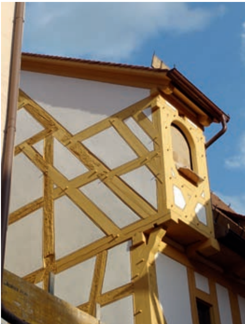
94 Gelungene Rekonstruktion des kleinen Aufzugserkers
