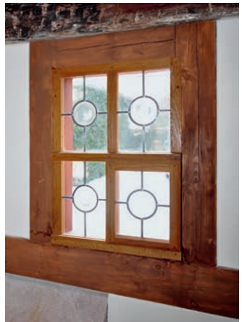
29 Rekonstruiertes Kreuzstockfenster mit Schiebeflügel im 1. DG
