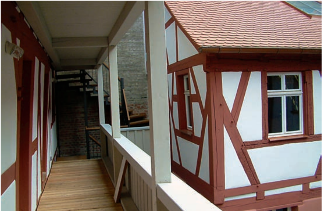
60 Die wiederbelebten Hofgalerien dienen als Balkone für die Bewohner. Rechts im Bild das Rückgebäude mit den auffälligen K-Streben.
