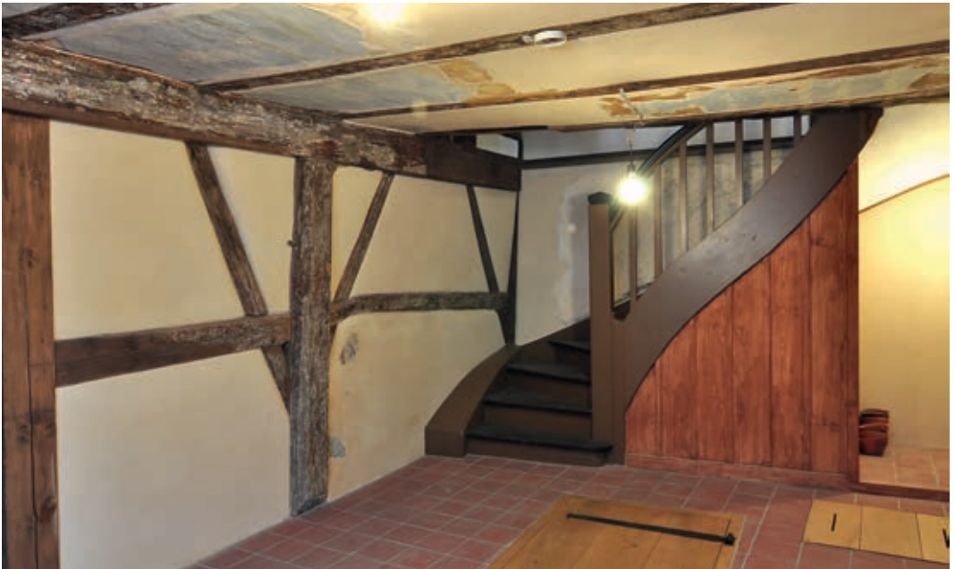
25 Die neuzeitliche Treppe in der ursprünglichen Diele führt den Museumsbesucher in das 1. OG.
