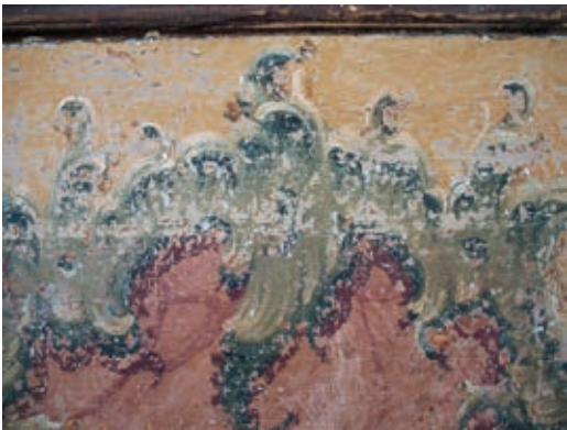
91 Die Befundlage der barocken Bemalung vor der Restaurierung
