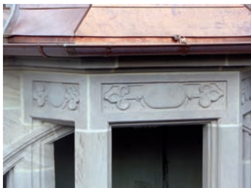
2 Neue Fensterstürze von 2013. Das Ornament des kleinen Fensters ist von der Fassade etwas abgerückt.
