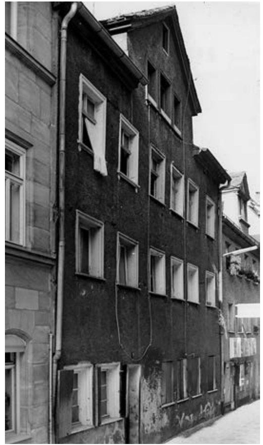
56 Das nicht mehr bewohnbare Haus vor der Sanierung
