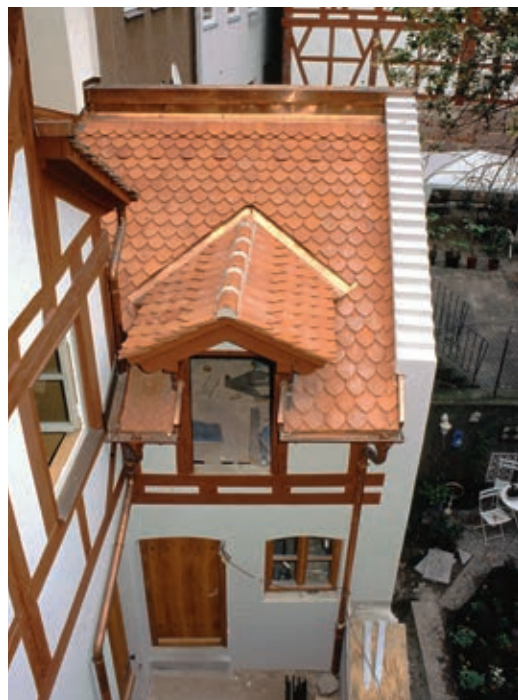
3 Die Sanierung des Rückgebäudes war 1998 fast abgeschlossen.
