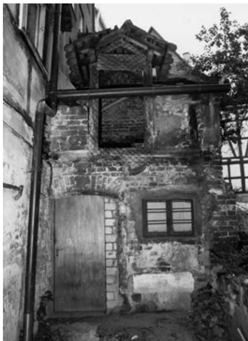
2 Das ursprünglich als Stall genutzte Rückgebäude im Vorzustand 1997
