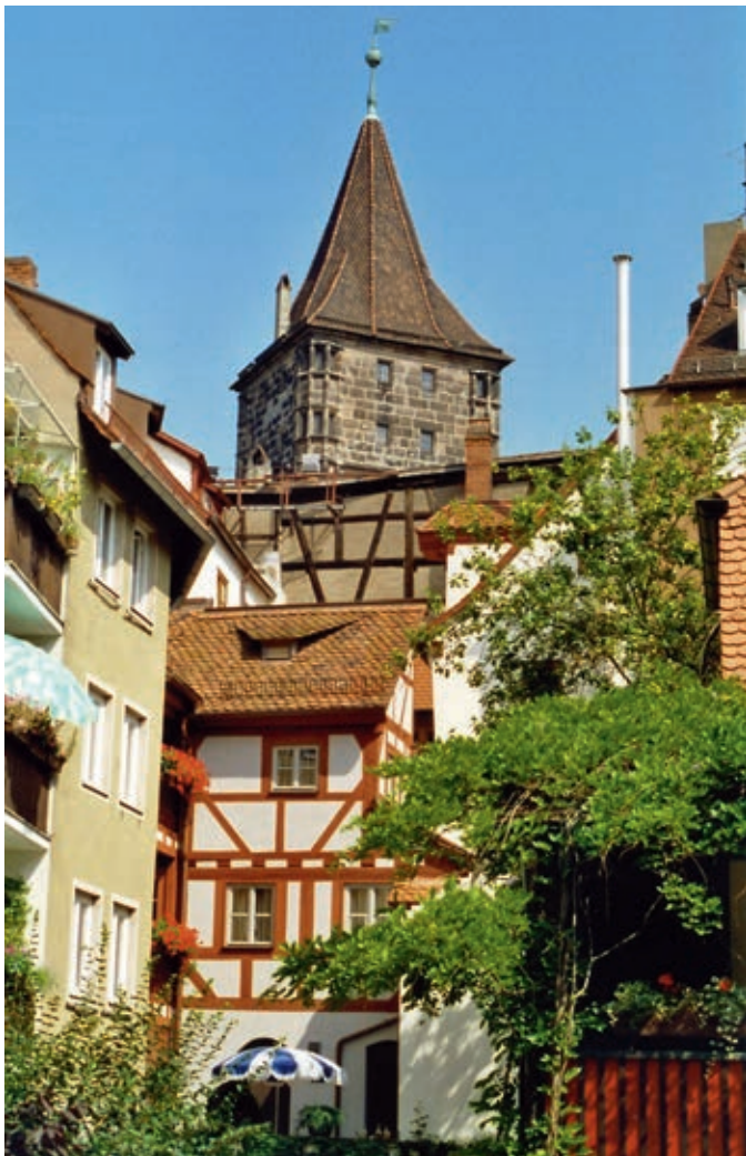
7 Blick auf den fertiggestellten Seitenflügel von Süden, im Hintergrund der Tiergärtnertorturm
