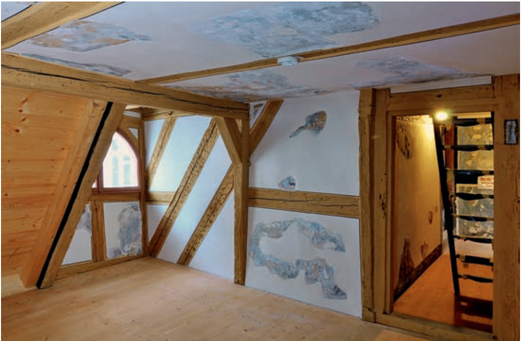
33 Durch die Fenster des Aufzugserkers fällt Licht in das Dachgeschoss. Die heruntergelassene Leiter führt in den Spitzbogen.
