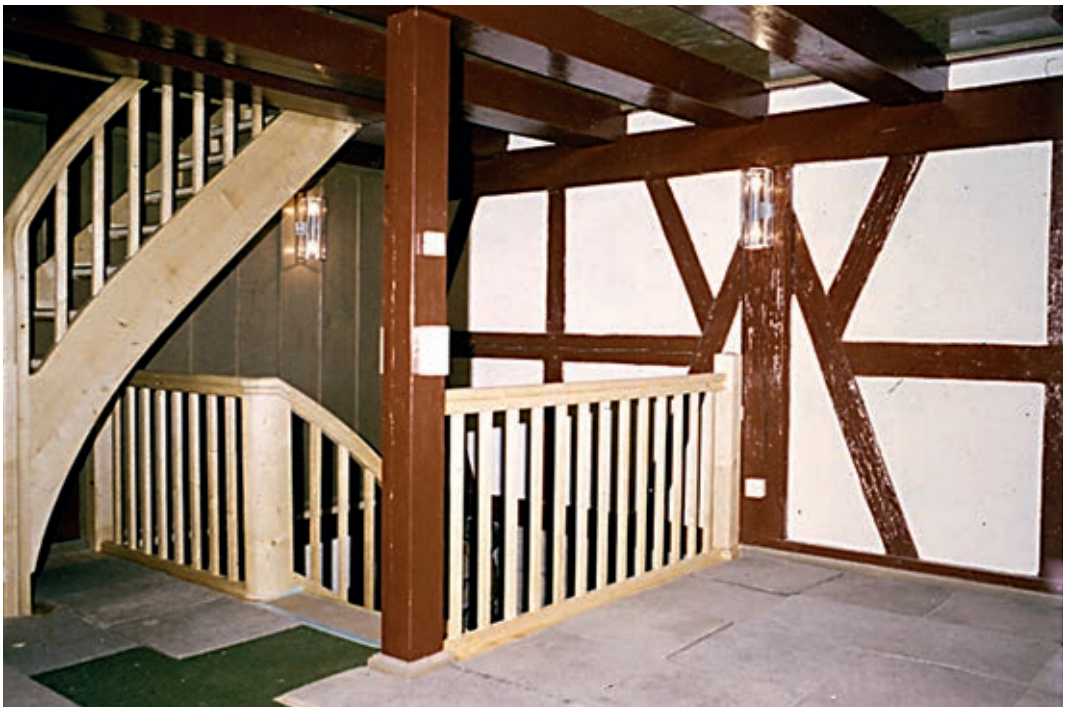
12 Die neue Treppe im 1. OG des Hinterhauses
