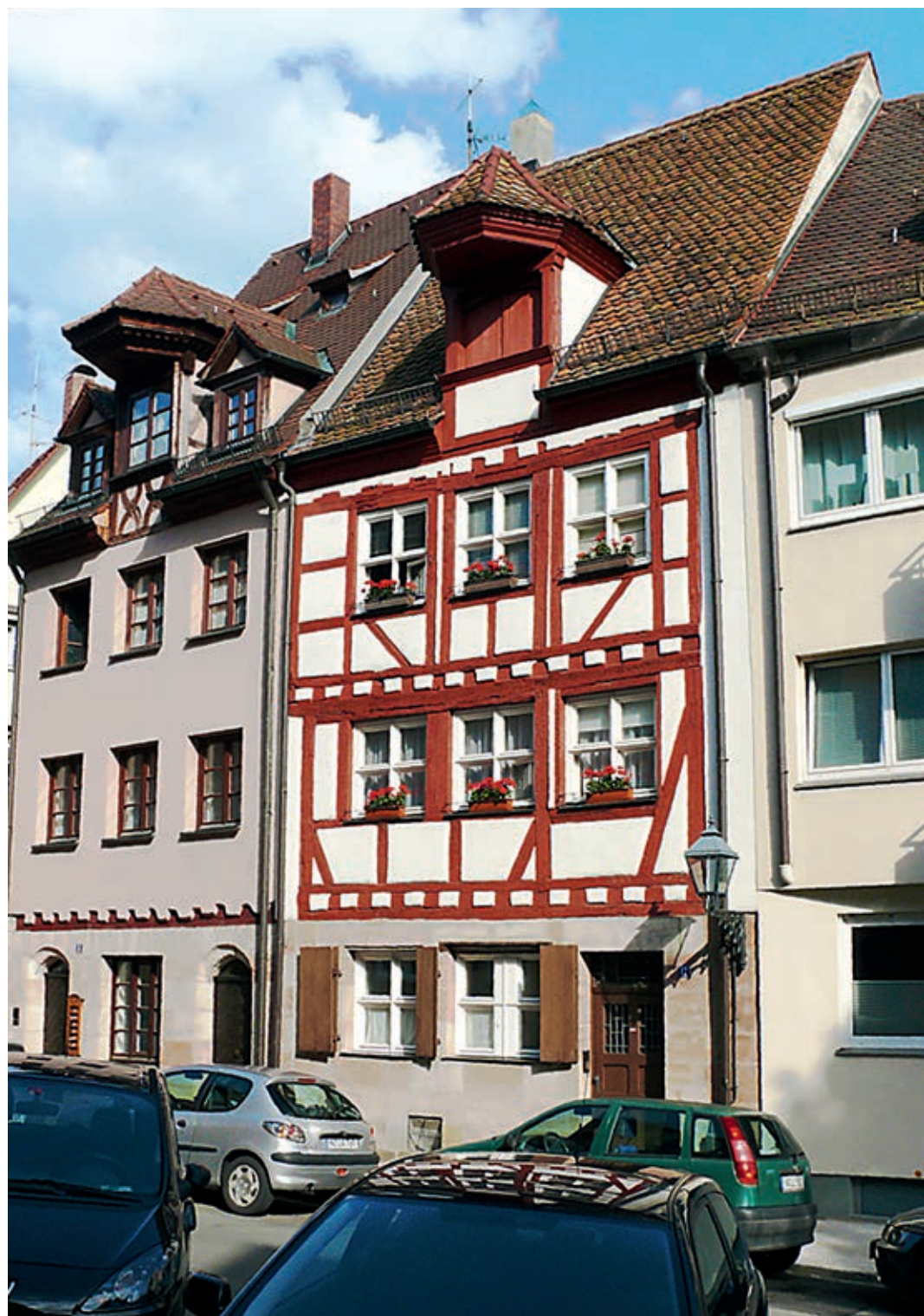
17 Freigelegte Fachwerkfassaden beleben das Straßenbild.
