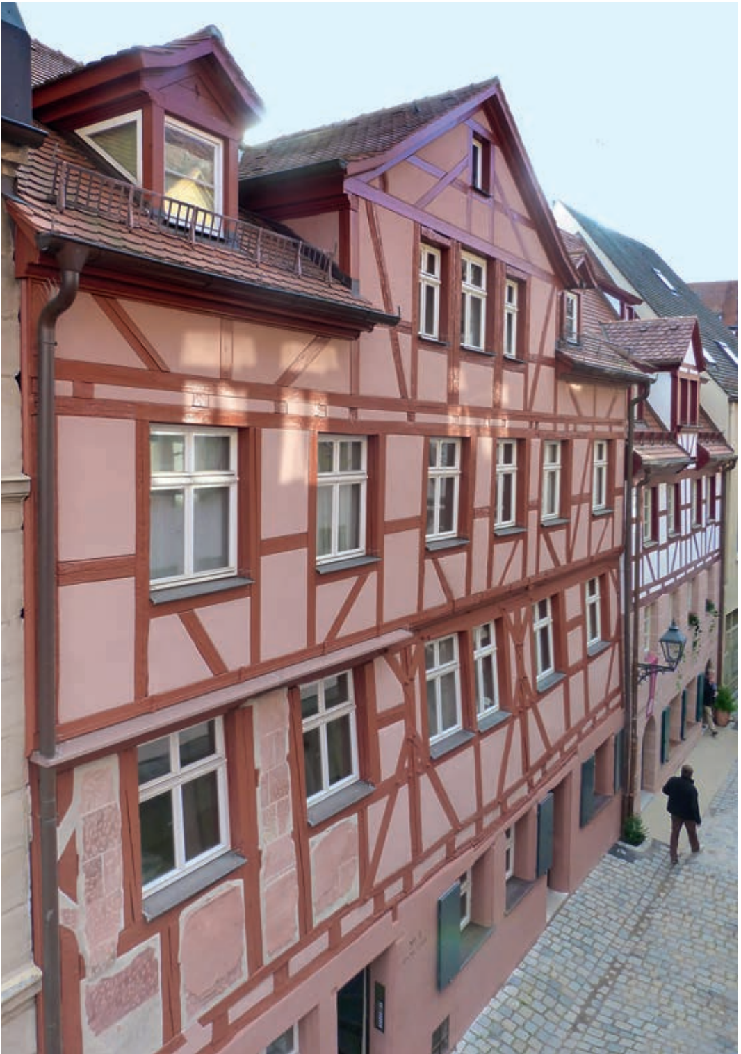
55 Die verschiedenen Rottöne der Fassade ziehen die Blicke in der Pfeifergasse auf sich.
