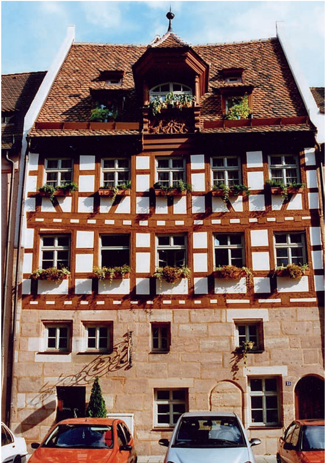
69 Das Musterbeispiel einer gelungenen Sanierung eines Nürnberger Handwerkerhauses
