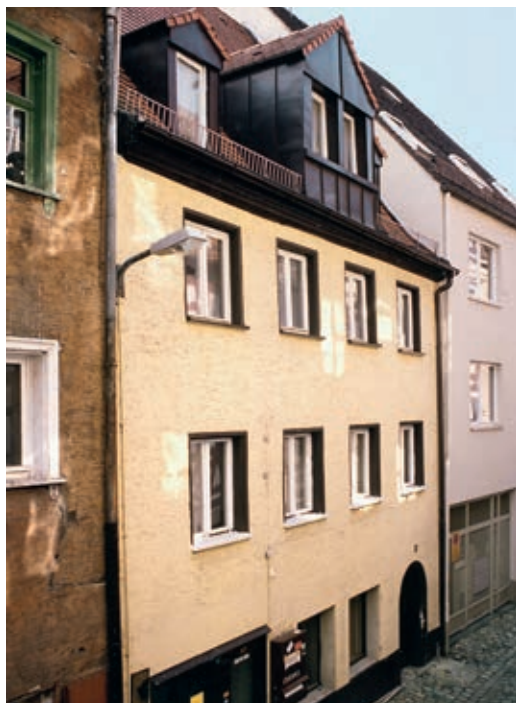
62 Wie alle anderen Gebäude in der Pfeifergasse war auch die Nr. 9 vor der Sanierung komplett verputzt. Das Fachwerk konnte man nur vermuten.
