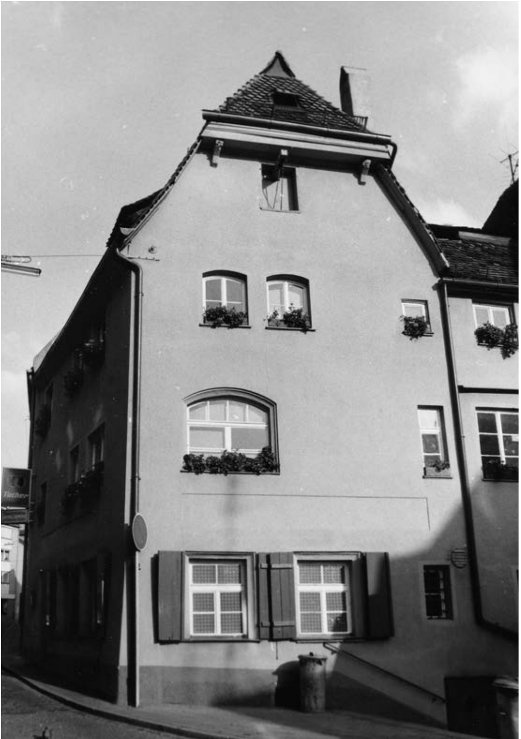
15 Das schmucklos verputzte Eckhaus vor der Renovierung
