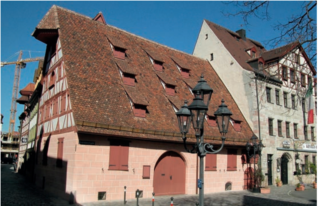
96 Mit der Sanierung der Scheune in der Zirkelschmiedgasse/Ecke Pfeifergasse begann das Engagement der Altstadtfreunde im „Glasscherbenviertel“.
