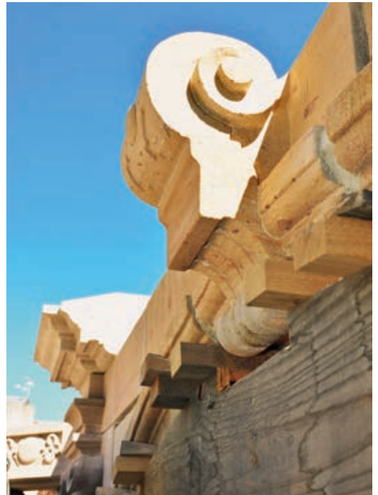
7 Ein ungewöhnlicher Anblick vor dem Aufmauern des Traufgesimses
