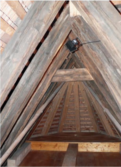
99 Die Innenseite des Aufzugswalms mit Hahnenbalken
