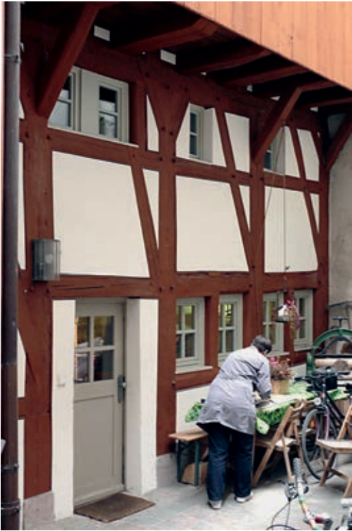
72 Die Hofseite zeigt noch die Fachwerk- konstruktion des 15. Jh. mit Ständern bis zum Erdboden.
