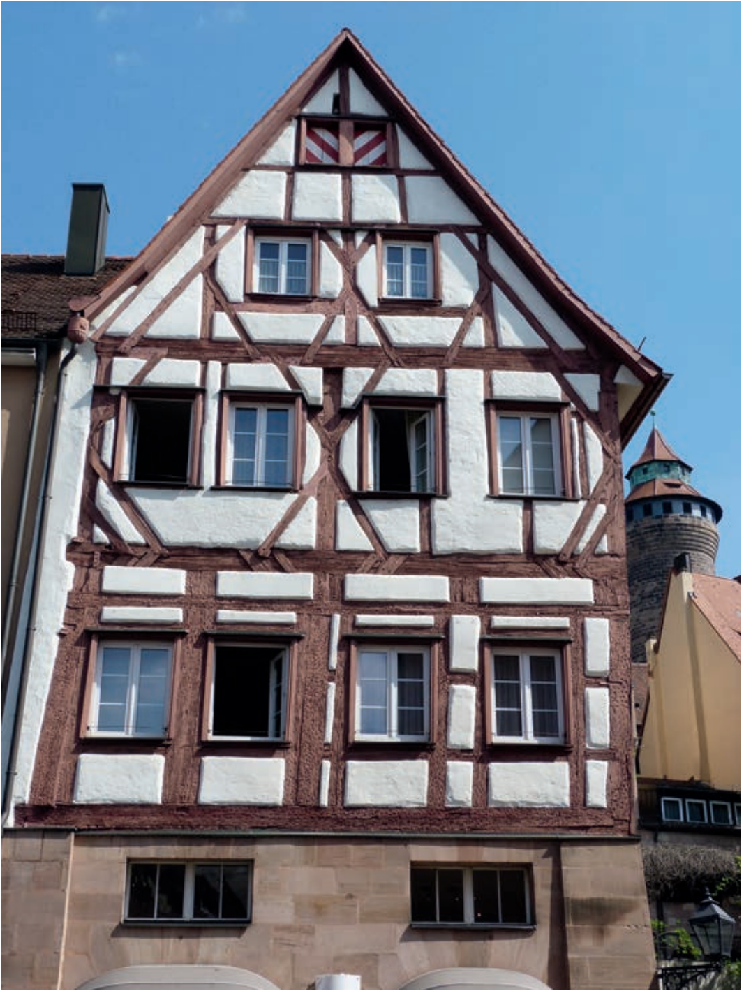
1 Am freigelegten Fachwerk des Merianhauses in der Bergstraße 10 lassen sich die Konstruktion aus der Bauzeit vor etwa 1500 und die späteren Veränderungen deutlich ablesen.
