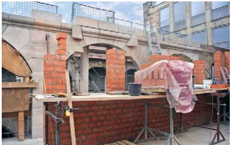
4 Der Seitenflügel entsteht aus Backsteinen. Rechts ist (dunkel) der originale Bogen erkennbar.
