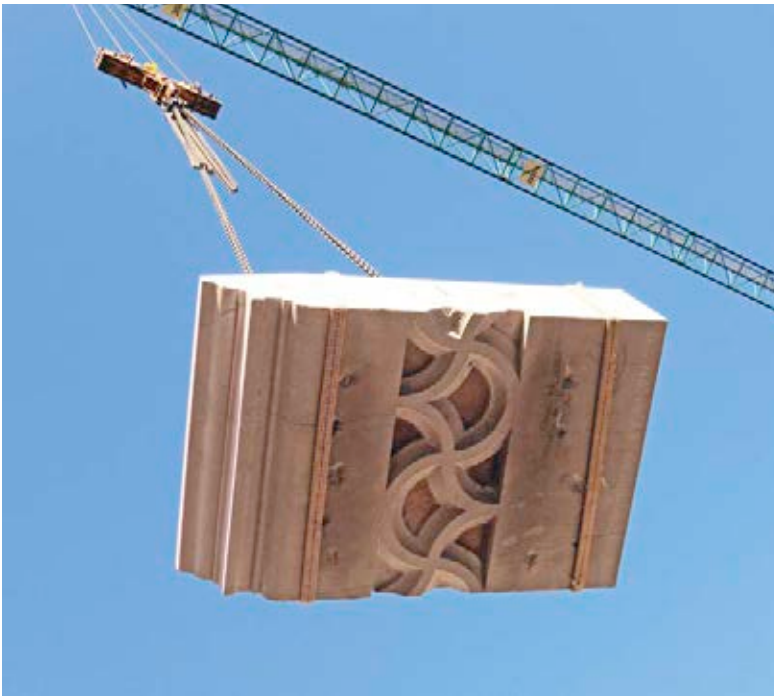
1 Die Decke des Chörleins am Haken: unten mit einem Maßwerk geziert, links das Traufgesims
