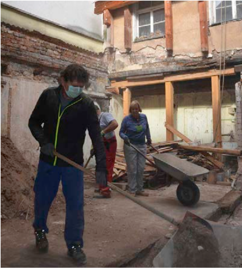
18 Dank der Baugruppe endlich wieder frei: der Hof in der Hinteren Ledergasse 43
