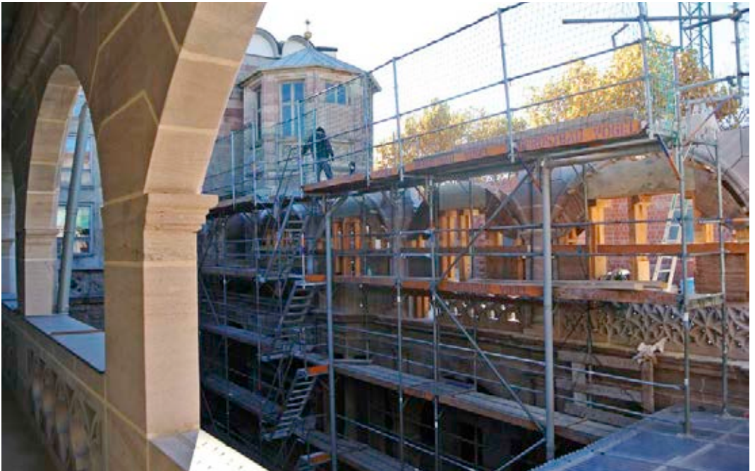
8 Die Westfassade im Aufbau
