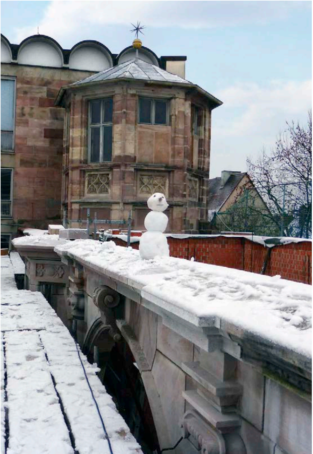
Ein kurzes Aufbäumen des Winters vor dem Einbringen der Betondecke
