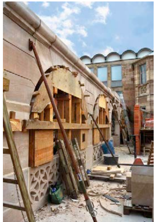
9 Die fertiggestellten Arkaden vor dem Ausbau der Leegerüste
