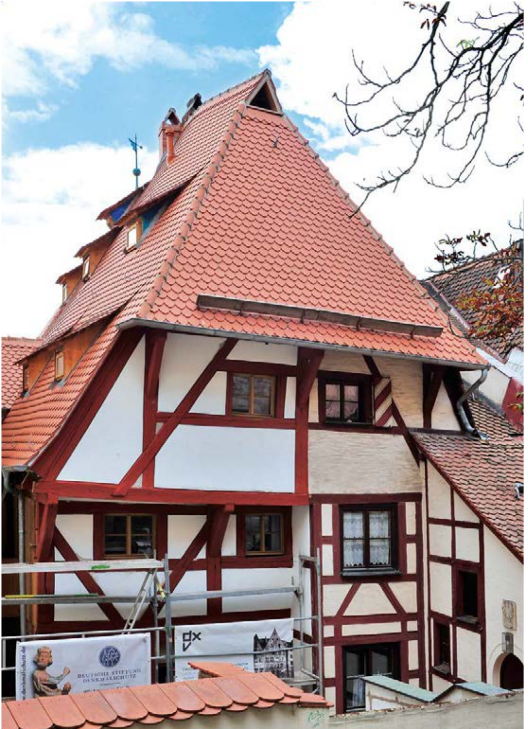
8 Obere Schmiedgasse 54/56, vom Ölberg aus gesehen, Baujahr 1338 Waldach mit trapezförmiger Dachfläche und Rauchloch. Zwei Auskragungen schützen die Giebelfassade vor dem Wetter und vergrößern die Grundfläche im 1. Dachgeschoss. Foto 2017
