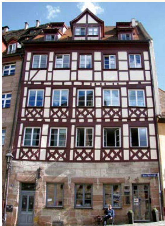
29 Obere Wörthstraße 21 Geschweifte Andreaskreuze. Die Kreuzungspunkte sind an der Ober- und Unterseite genast und enthalten jeweils ein kreisrundes verputztes Auge (1560). Foto 2017
