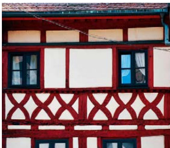
30 Zirkelschmiedgasse 28 (Hoffassade) Geschweifte Andreaskreuze mit geschnitzter Oberfläche (1560). Darüber Fenstererker mit gezahntem Brüstungsriegel. Konsolen zur Unterstützung des Brüstungsriegels konnten nicht nachgewiesen werden (1560). Foto 2017
