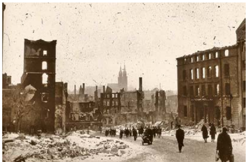
6 1945 ragt die Nordwand des Turmhauses alleine aus dem Trümmerfeld
