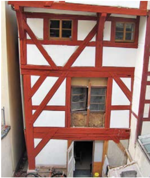
9 Obere Schmiedgasse 54/56 (Burgseite) Ständergeschossbau von 1338 – worauf der erneuerte, doppelstöckige Eckständer hinweist. Darüber ein Stockwerk in Stockwerkbauweise, das ebenso der Bauzeit angehört. Foto 2017
