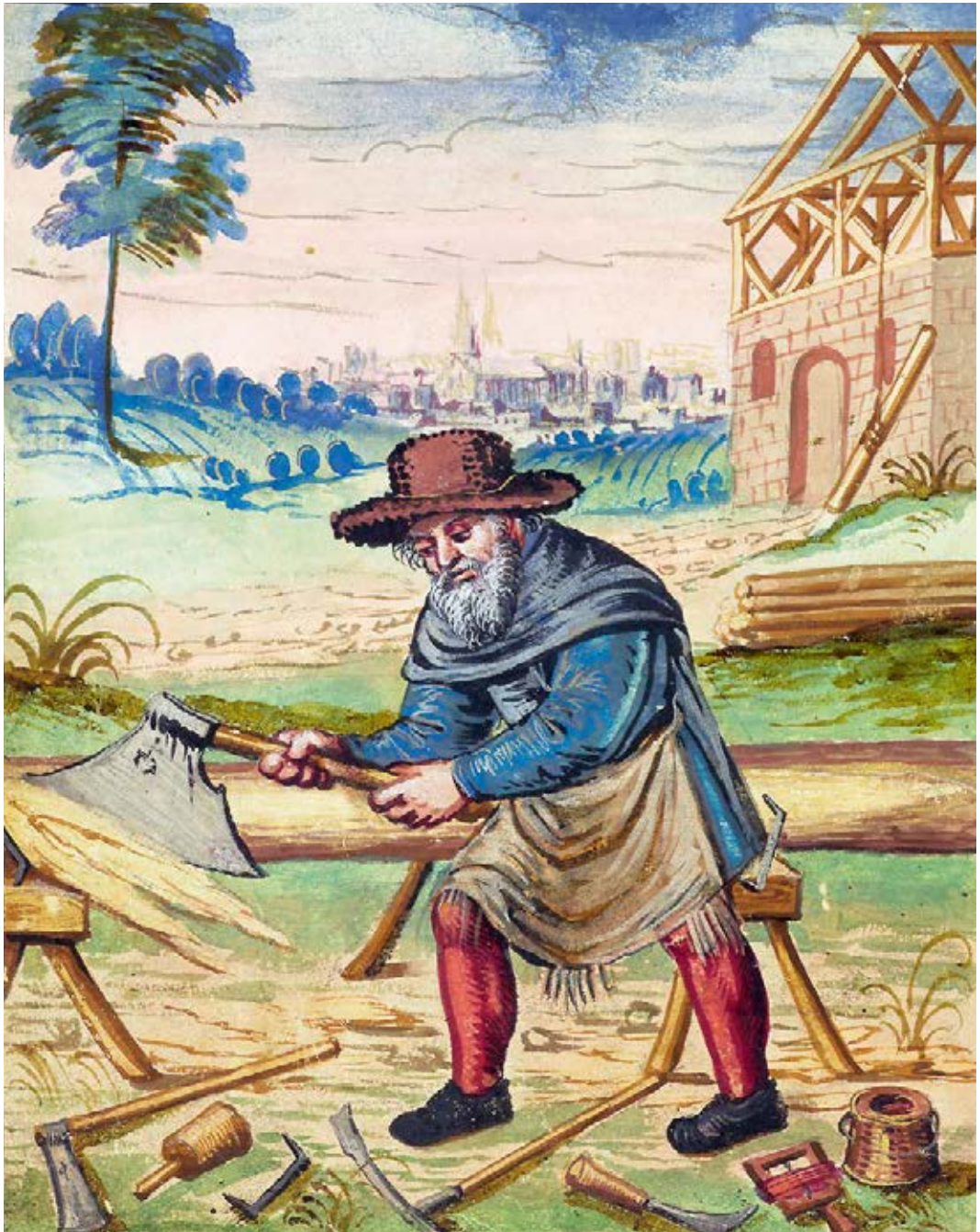
5 Der Zimmermann glättet mit dem Breitbeil die Holzoberfläche. Hausbuch der Mendelschen Zwölfbrüderstiftung. Jacob Muelbauer, Zimmermann, 1602
