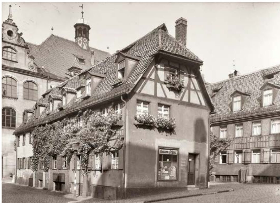
38 Sieben Zeilen 14-18 (1944 zerstört) Der Rat ließ 1489 für die angeworbenen Weber aus Schwaben fünf Zeilen mit je drei Häusern errichten. Die Zimmerleute erstellten die Häuser noch mit verblatteten Streben und mit Halbwalmdächern, die auskragten, eine trapezförmige Dachfläche sowie ein Rauchloch aufwiesen. Foto 1943
