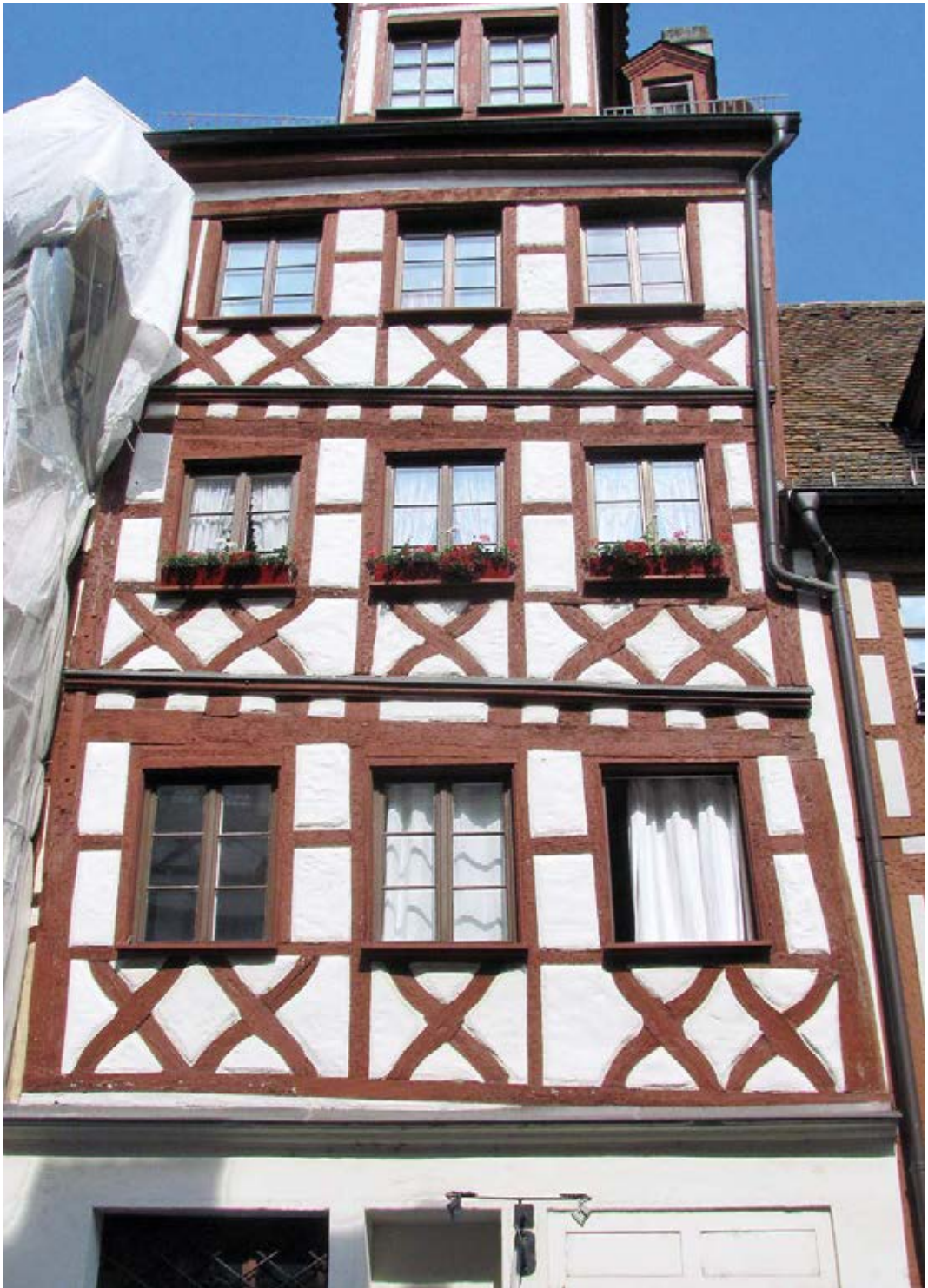
28 Albrecht-Dürer-Straße 32 In allen drei Stockwerken geschweifte Andreaskreuze in einfacher Ausführung (ohne Schnitzwerk und Nasen) zur schmuckhaften Gestaltung der Fassade (1564). Foto 2017
