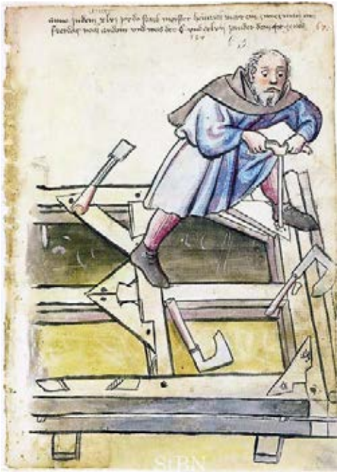
7 Eine Fachwerkwand liegt zusammengebaut auf dem Reißboden (Abbundplatz). Der Zimmermann bohrt gerade mit einem Hand- bohrer die Löcher für die eichenen Holznägel. Hausbuch der Mendelschen Zwölfbrüderstiftung. Heinrich Meyr, Zimmer- mann, 1446
