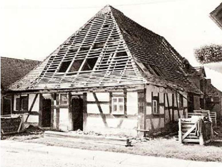
40 Schäferei aus Hambühl von 1744 Abgebaut 1979 und im gleichen Jahr im Fränki- schen Freilandmuseum Bad Windsheim wieder- aufgebaut. Die Walmsparren verlaufen rechtwinklig zur Traufe und sind an die Gratsparren, die die Walmfläche begrenzen, angeschiffet. Eine Bauweise, die in der Stadt seit etwa 1525 angewandt wird und heute noch ihre Gültig- keit hat. Foto 1979
