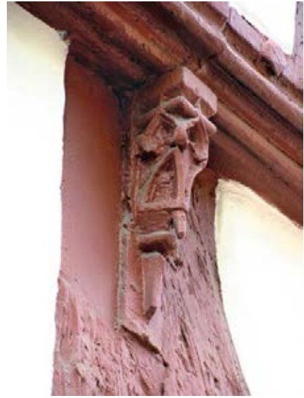
35 Augustinerstraße 7 Geschnitzte Konsole mit gotischer Ornamentik (z.B. Spitzbogen) zur Unterstützung des profilierten Brüstungsbalkens bzw. Fenstererkeres. Als separates Bauteil in die Ständer und Stiele mittels eines Zapfens eingebaut (1. Hälfte 15. Jh.). Foto 2017
