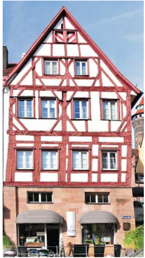
12 Bergstraße 10. Das 2. OG, das 1. und 2. DG zeigen noch die bauzeitliche Fachwerkarchitektur von 1412. Anhand der abgeschnittenen Blätter (ehem. Kopfstreben) im Schwellholz des 2. OG kann man das Fachwerk im 1. OG rekonstruieren. Foto 2012
