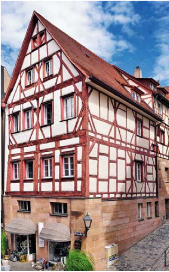
11 Bergstraße 10 (Wohnhaus von Maria Sibylla Merian und Johann Andreas Graff). Fachwerkbau von 1412 in Stockwerkbauweise errichtet. Der Austausch des bauzeitlich verbläteten Fachwerks gegen das Riegel-fachwerk bzw. Sandsteinmauerwerk erfolgte in der zweiten Hälfte des 17. Jh. Foto 2017
