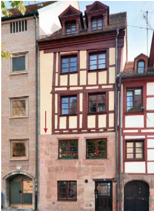
24 Belohnung für eine private Sanierung: Der Sandsteinstreifen links ersetzt die moderne Kaschierung des Abbruchs nebenan.
