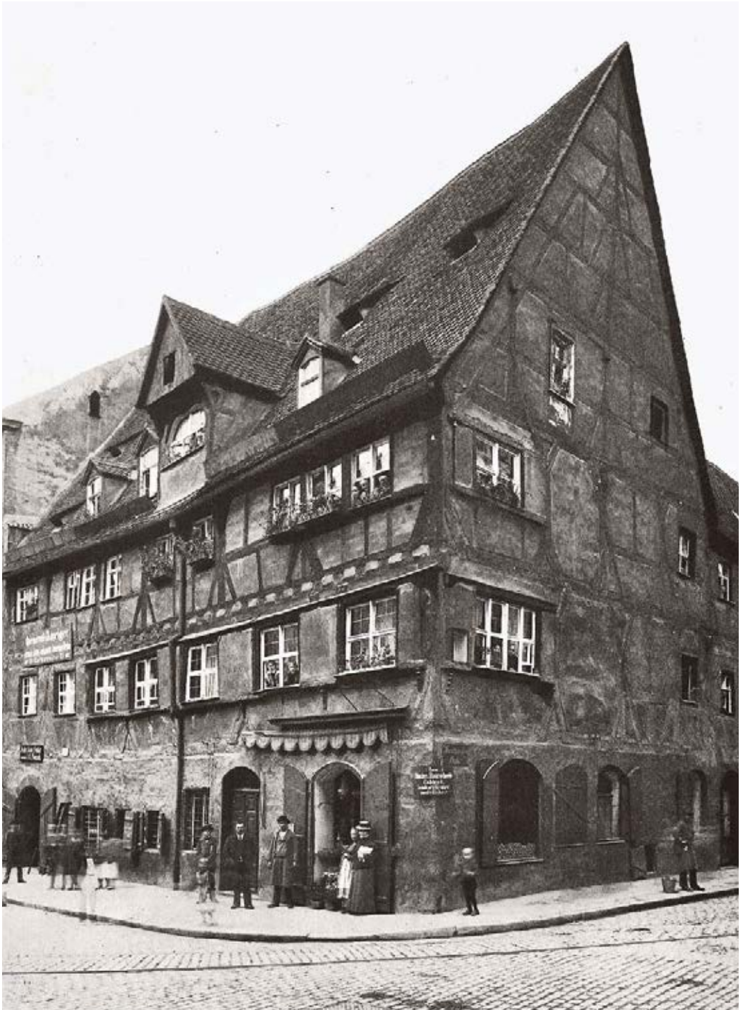
5 Das Zachariasbad, Karlstraße 9/Weintraubengasse. Der mittelalterliche Fachwerkbau und der Aufzugserker dürften in der ersten Hälfte des 15. Jh. entstanden sein, worauf die Fachwerkkonstruktion hinweist. Abgebrochen 1899. An seiner Stelle steht heute das Sozialgericht. Aufnahme von Ferdinand Schmidt, 1875-1899.
