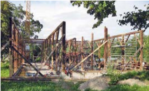
27 Fachgerechter Abbau des Stadels in Kolbermoor.
