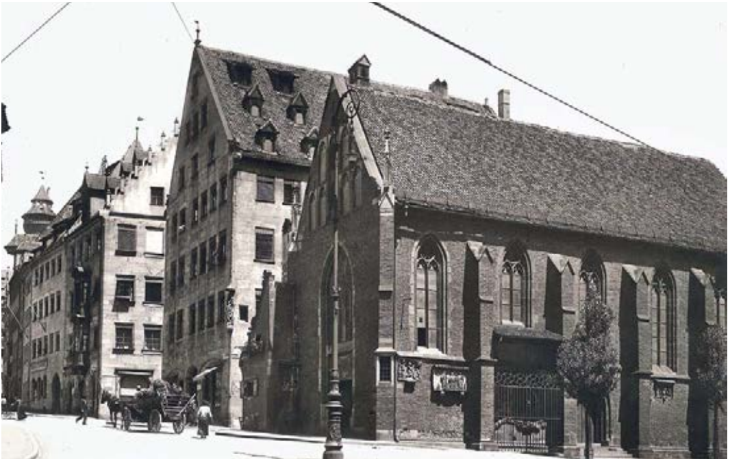
1 Die Moritzkapelle am Sebalder Platz von Südwesten aus gesehen. Die schlichte Backsteinarchitektur bestimmt das Bild der Kapelle, nur die gotischen Sandsteingewände der Fenster und Türen treten schmuckhaft hervor. Aufnahme von 1917.
