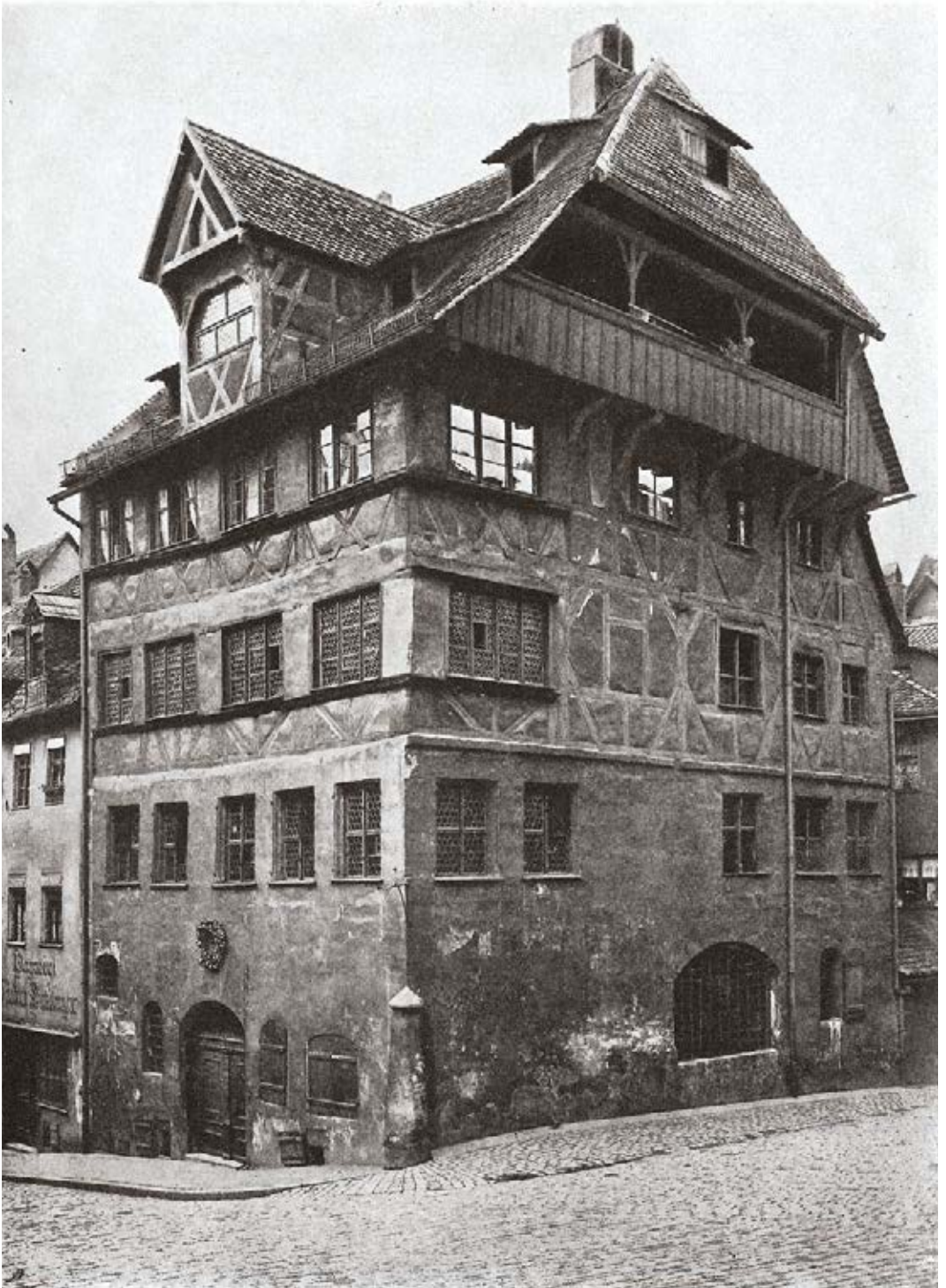
6 Seit 1899 hat das Albrecht-Dürer-Haus wieder einen Aufzugserker. Die Albrecht-Dürer-Stiftung hat den Aufzugserker vom Abbruchgebäude Karlstraße 9 (Zachariasbad) auf das Albrecht-Dürer-Haus versetzen lassen. Aufnahme von Fritz Traugott Schulz, Juni 1905.
