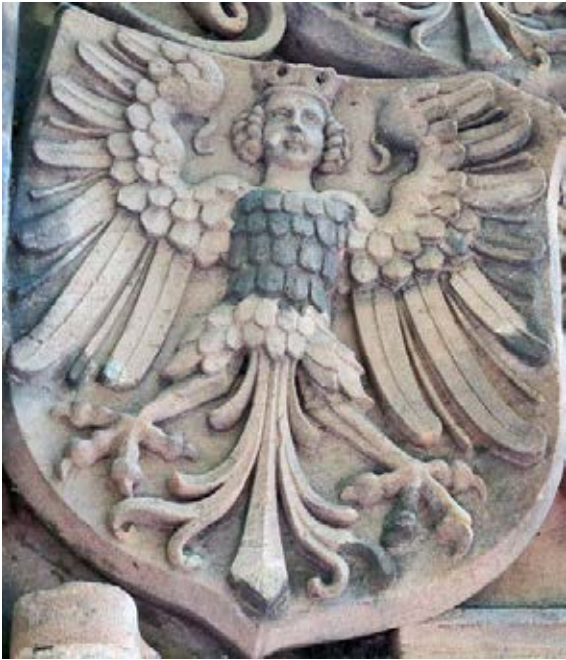
13 Am Martin-Behaim-Denkmal: Hier wurde mittels Stein-Ersatzmasse nachträglich für Moral gesorgt. Die Masse erweist sich als nicht farbecht.
