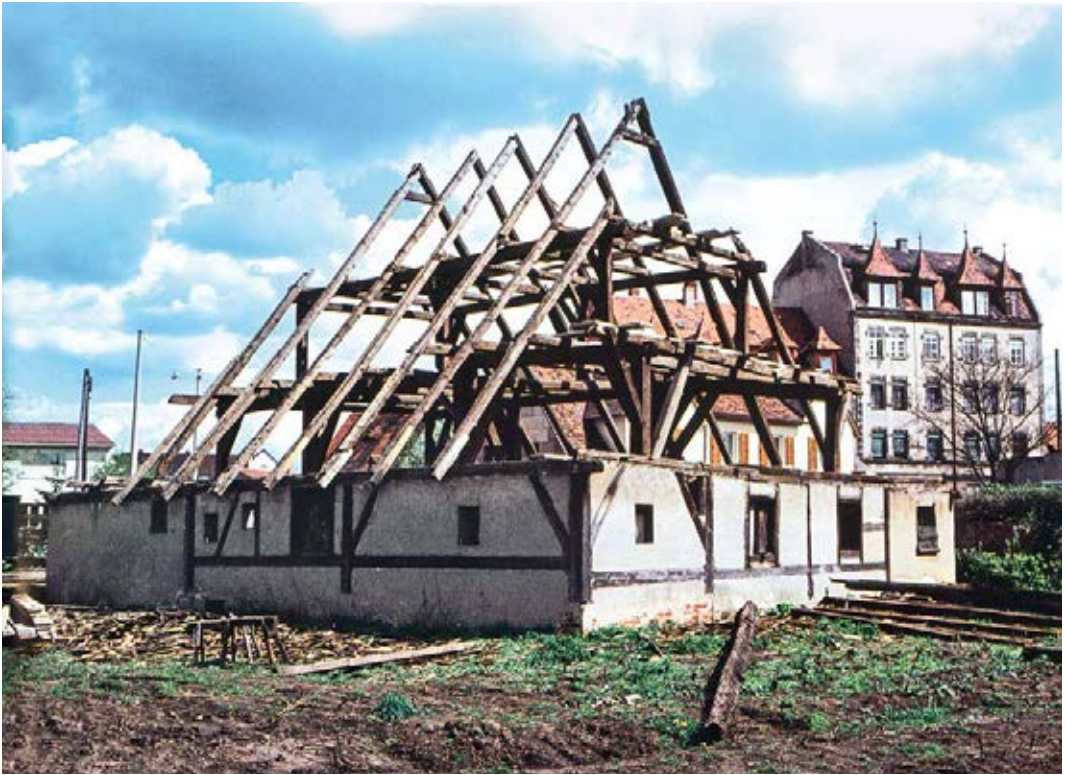
15 Abbau des Schwedenhauses, Äußere Bucher Straße 33. Die Walm- und Gratsparren sind bereits abgebaut, was den Blick auf das doppelstöckige Innengerüst ermöglicht. Aufnahme von 1966.
