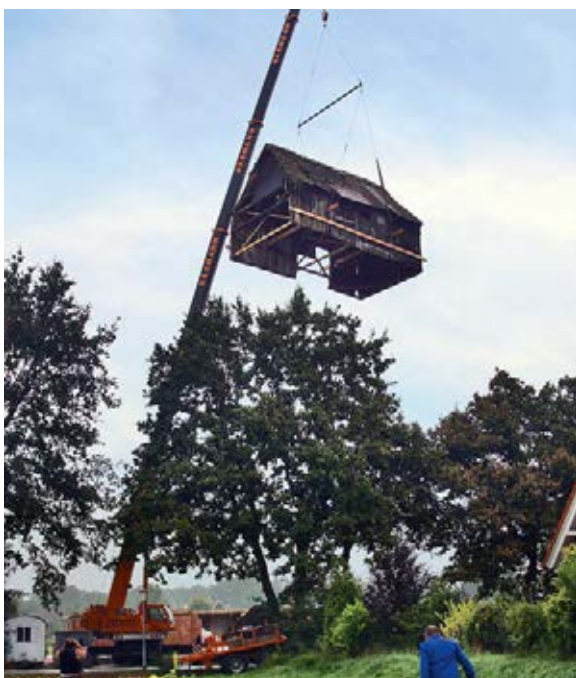
24 Ein Autokran versetzt die Scheune auf ein 150 m entferntes Grundstück. Transportvorbereitung und Versetzung erfolgten am 24. und 25.9.2002.
