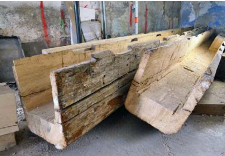
26 Der ausgehöhlte Unterzug im Erdgeschoss vor seinem Wiedereinbau zur Umhüllung des Stahlträgers
