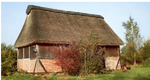
25 Die Scheune an ihrem neuen Standort und nach erfolgter Instandsetzung. Ein schönes Beispiel, wie ein Gebäude dank Translozierung erhalten werden kann.
