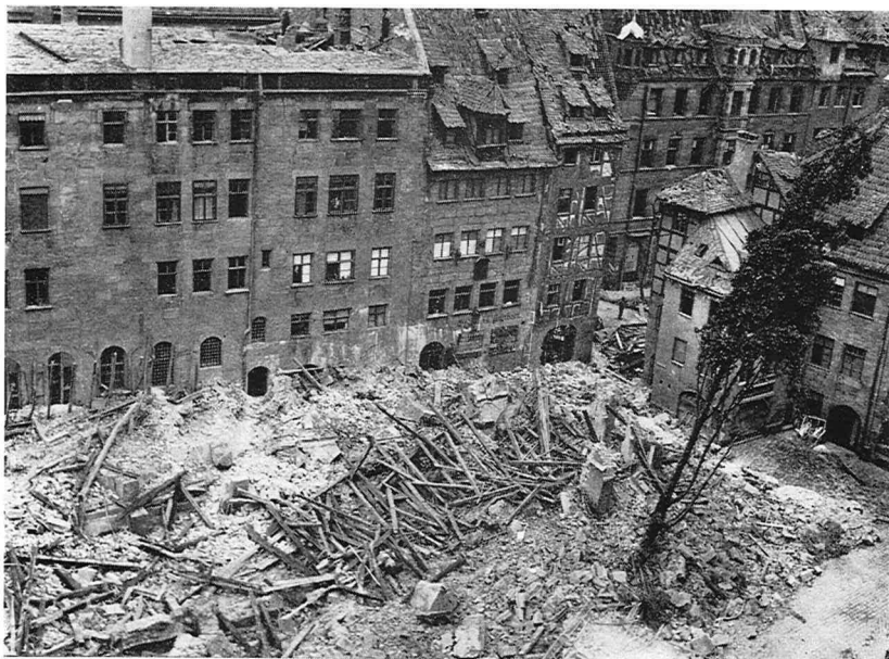
8 Moritzkapelle und Bratwurstglöcklein nach dem 3. Oktober 1944. Hier müssen mehrere Volltreffer eingeschlagen sein, die das Gebäude förmlich zerlegt haben.
