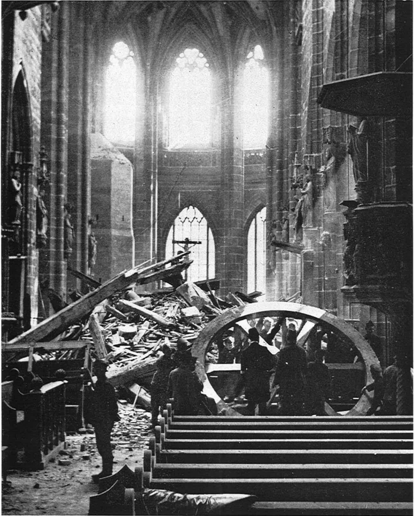
4 In der Lorenzkirche vier Tage nach dem Angriff vom 10./11. August 1943. In der Mitte der Schutt der eingestürzten Langhausgewölbe, bedeckt von Teilen des Dachgebälks. Das Rad gehört zur Aufzugsvorrichtung des Vischer-Leuchters. Dem Chor im Hintergrund sieht man seine schwere Erschütterung höchstens an den herausgeschlagenen Gewölbekappen an. Links die bunkerartige Ummantelung des Sakramentshäusleins.
