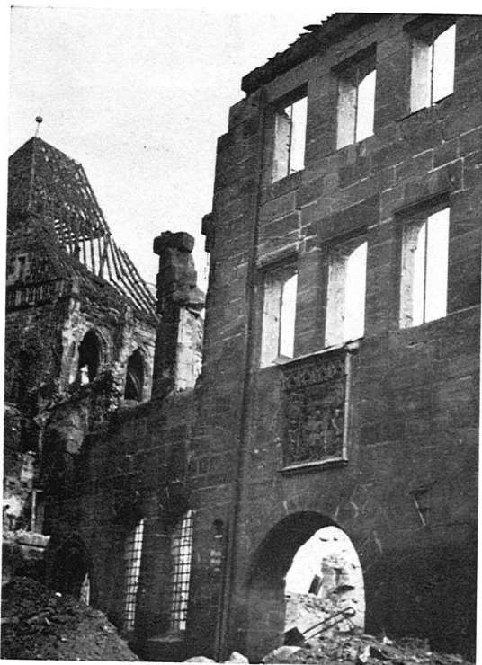
Das Waagmeisterrelief an der Hauswand der zerstörten Alten Waage. Aufnahme 1945.
