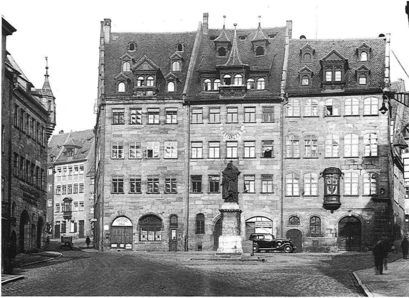
49 * Albrecht-Dürer-Platz 14-18 vor dem Krieg. Die drei Häuser deutlich als Einzelbauten kenntlich gemacht (Dacherker, Brandmauern, Trauf- und Firstsprünge, verschiedene Fenster).
