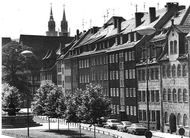
Maxplatz 7—29 nach dem Wieder- aufbau 1972
