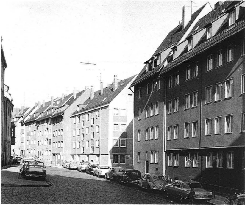
43 Nachkriegsneubauten Schildgasse 2—14. Schlichte Fassaden, in der Gliederung ihren Vorgängern nicht ebenbürtig. Foto 1966.
