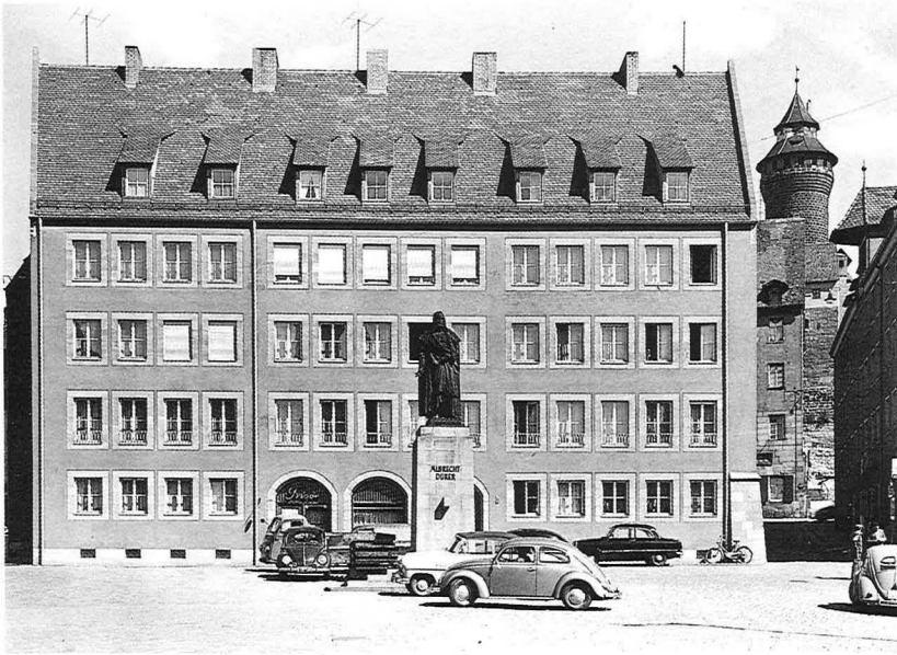
50 Dieselben Häuser nach dem Wiederaufbau. Trotz der verschiedenen Besitzer völlige Vereinheitlichung. Bezeichnenderweise erhielt auch das Denkmal einen grob-monumentalen Sockel.
