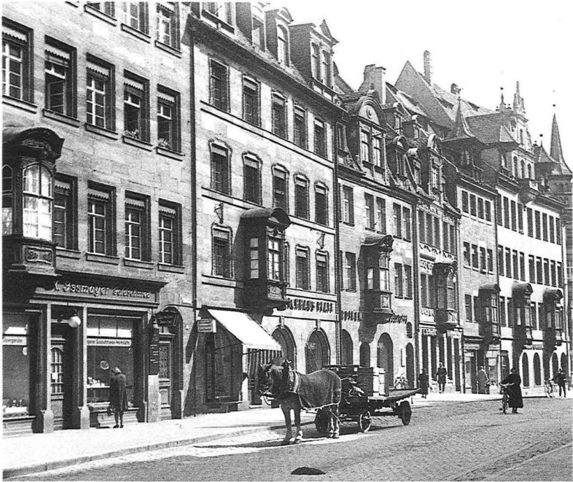
2 *Adlerstraße 28-40. Fassaden ganz verschiedenen Alters, zusammengeschlossen durch eine lückenlose Chörleinkette.
