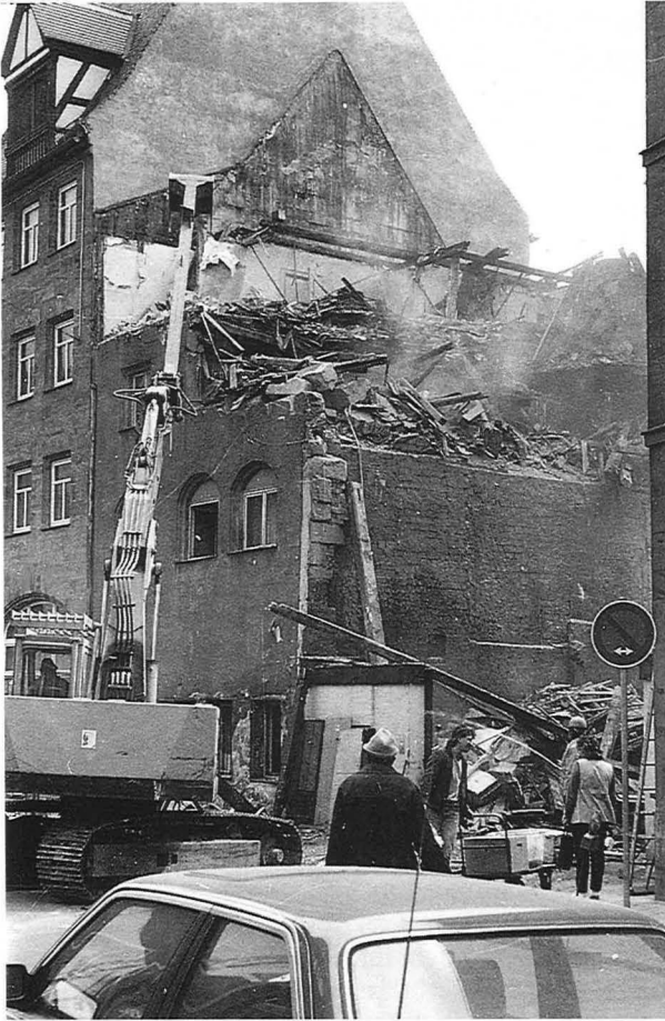
Ein altes Haus weniger: Nürnberg ärmer gemacht durch erbarmungslosen Abbruch Hintere Ledergasse 33
