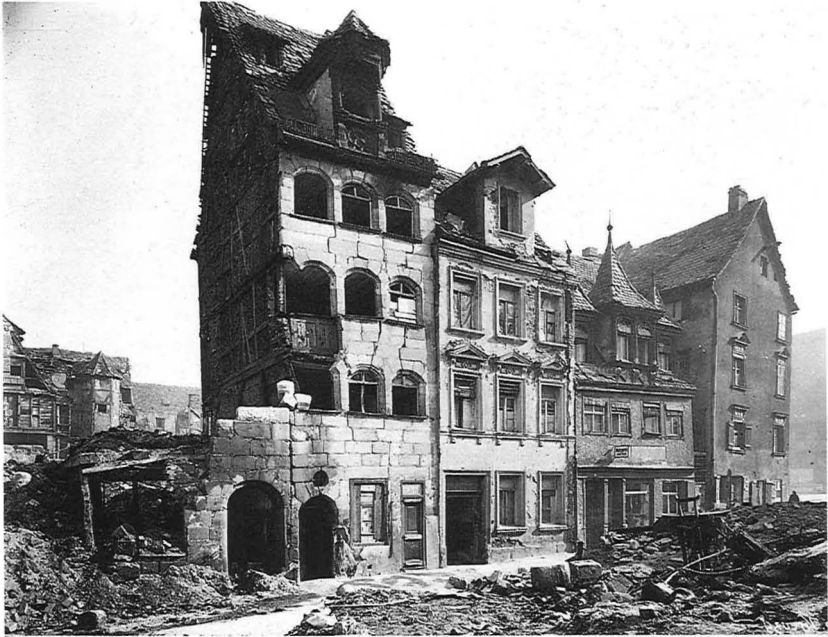
3 Obere Kreuzgasse 6, 4, 2 und Unschlittplatz 12. Aufnahme 1946. Abbruch der beiden linken Häuser vor 1951. Die beiden anderen 1978 durch die Altstadtfreunde gerettet.
