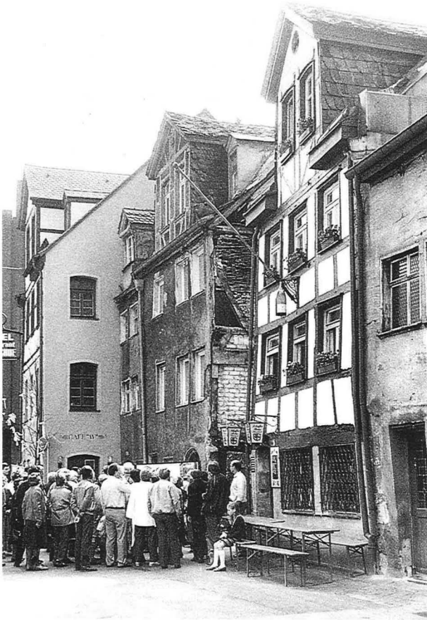
Protest beim Altstadtspaziergang: Eine von fünfzig Führungs- gruppen vor der Abbruch- lücke Johannes- gasse 57 und dem leerstehenden Doppelhaus Johannesgasse 53/55 (hinter der Schautafel)
