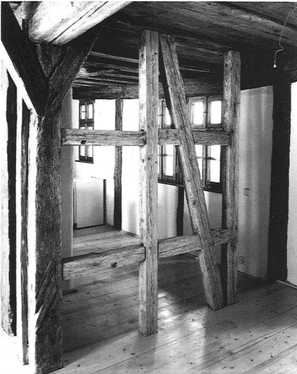
Dieselbe Stelle, Endzustand. Die ehemaligen Zwischenwand-Balken stehen frei im Groß-Wohnraum. Links oben eine ergänzte Kopfstrebe. Das Fachwerk der Außenwand ist hinter der Isolierung verschwunden; nur die (dickeren) Pfosten bleiben sichtbar.
