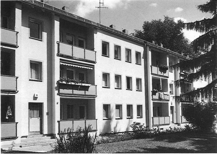
31 Die ersten Schritte in die Nachkriegsarchitektur: Oskar-von-Miller-Straße 19/21 (1949). – Es ist heute kaum mehr bekannt, daß die kleine Wohnanlage nahe dem Flachweiher als Musterbauvorhaben während der Deutschen Bauausstellung 1949 (im Kongreßhallengelände) entstand und die damals fortschrittlichsten Wohnformen und Bautechniken zeigen sollte.
