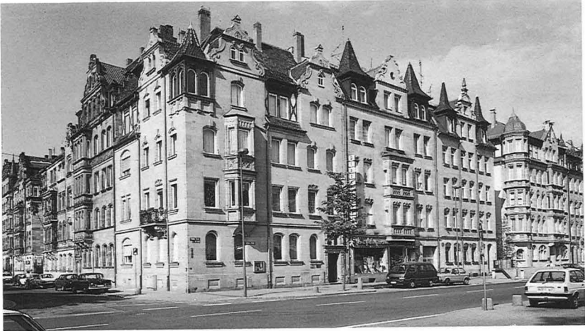
11 Ausgeprägter „Nürnberger Stil“: Glockendonstraße 10 – 2, Fürther Straße 81 – 83a (1895 – 1903)
