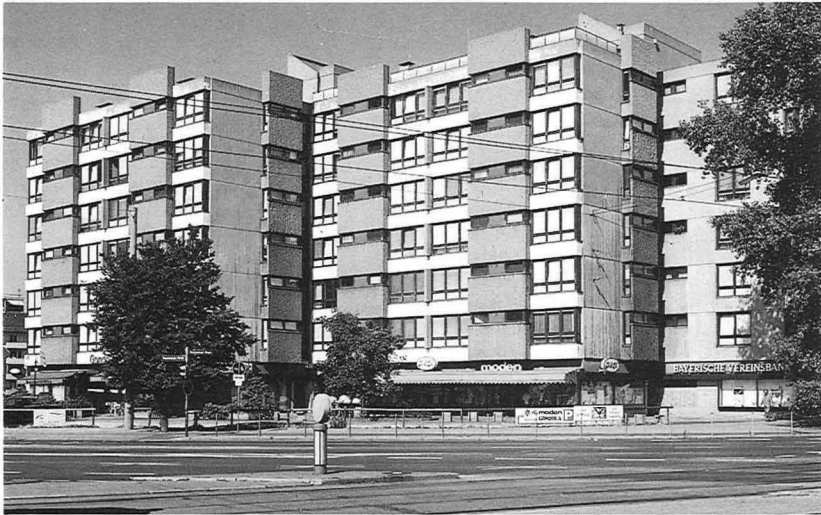
35 Wohnanlage Regensburger Straße 63 – 67
