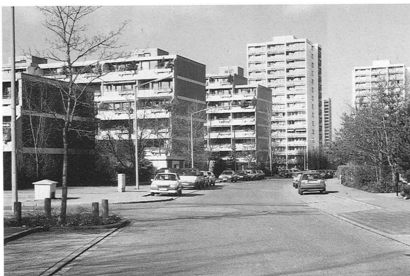
33/34 Oben: Wohnanlage Noricus. Südliche Randbebauung, gesehen von der Ostendstraße. Unten: Langwasser, Nachbarschaft U. Im Vordergrund die Zugspitzstraße. Blick nach Norden in Richtung Neuselsbrunn.
