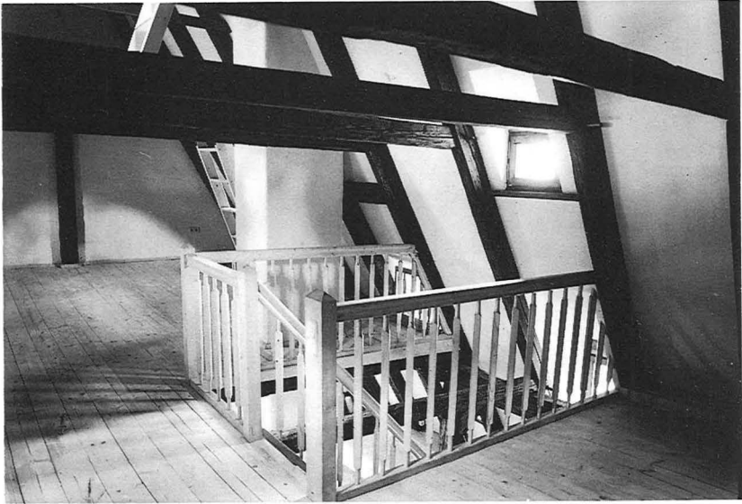
18 Unter den Sparren und (oberen) Kahlbalken des alten Dachstuhls liegt die zweite Ebene der Dachgeschoßwohnung.
