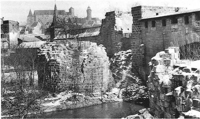
14/15 Oben: Sprengbombentreffer am 3. Oktober 1944. Der Schwibbogen hat ausgehalten. Unten: Zustand 1955 mit Schutzdach.
