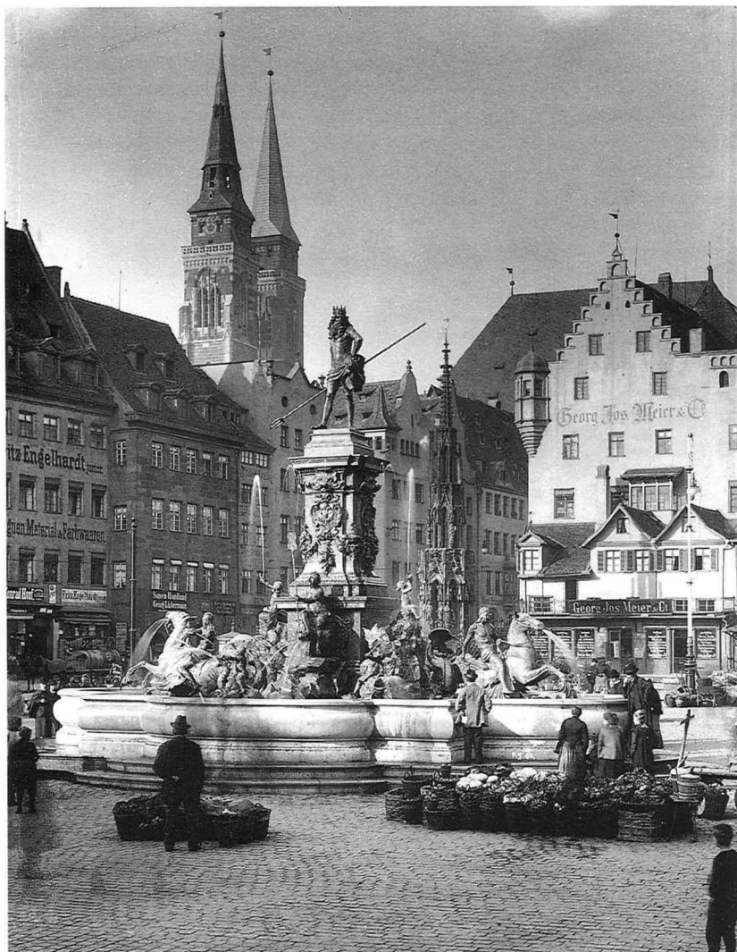
13 Der fertige Brunnen. Das enge Nebeneinander von Gotik und Barock hat auch seine Reize! Hinten in traurigem Zustand der Schöne Brunnen, der erst 1903 rekonstruiert werden wird.
