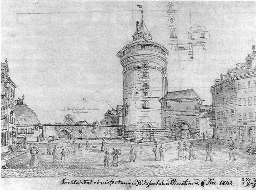
4 Die erniedrigte Mauer zwischen Salzstadel (links) und Frauentorturm. Bleistiftzeichnung von Georg Christoph Wilder; eigenhändig beschriftet: „Verkleinert abgeliefert an die K(önigliche) Eisenbahn Direction d(en) 6. Dec(ember) 1842.“
