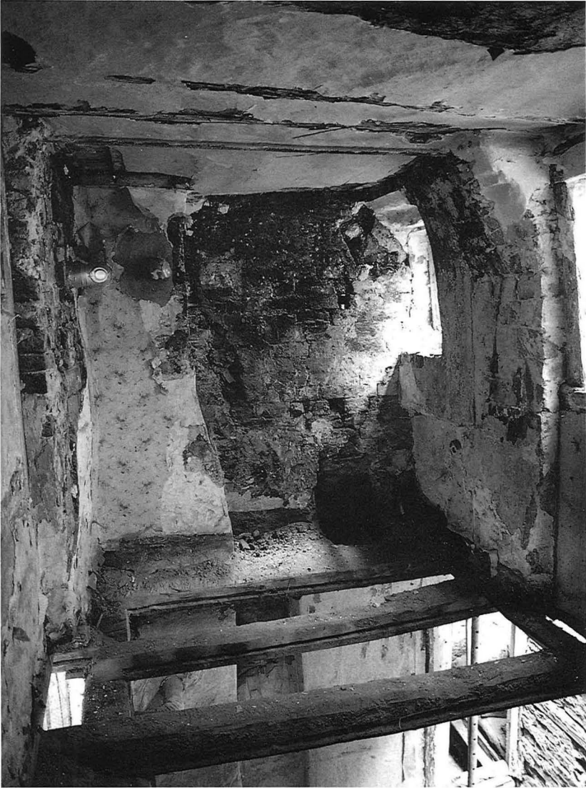
5 Zimmer zum Hof im zweiten Obergeschoß, Stand Oktober 1988. Rechts die „Millionenwand“ als Hausabschluß von 1342; sie steht auf den Deckenbalken, die ihrerseits einer weiter hinausgerückten (neueren?) Wand aufliegen. Der alte Kamin heute wieder in Betrieb.
