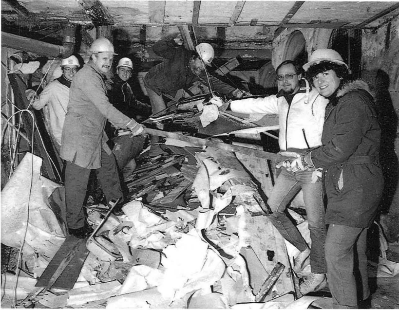
1 Leergut, Latten, Leitungen: Fototermin der Samstag-Arbeitsgruppe auf der anfänglichen Zwischenkippe im Hof.
