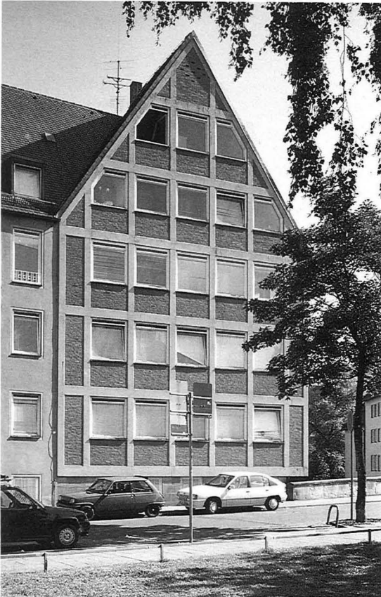
Die gestalterische Variationsbreite großzügiger ausge- schöpft: Karlstraße 2 (Architekt Karl Fischer, 1969). Aufnahme 1992.
