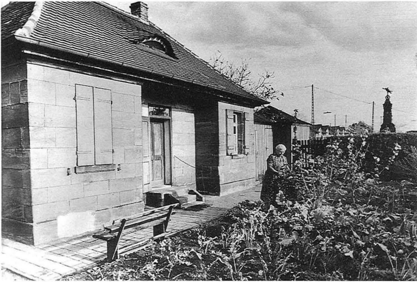
11 Rechts hinten das Denkmal. Vorn das Bahnwärterhaus von 1835: Ein klassizistisch-biedermeierlicher Sandsteinbau mit eingezogenem Mittelteil (wohl als geschützter Platz für den Posten gedacht). Der Abriß dieses ältesten Eisenbahnbauwerks Deutschlands im August 1967 war eine unverzeihliche historische Barbarei.
