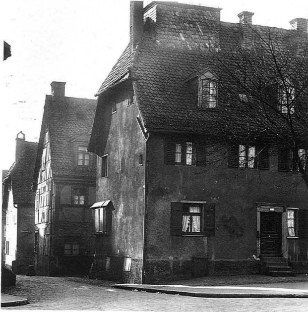
Zum Stadtbild- Vergleich: Die Nordostecke der Sieben Zeilen 1930. Sichtbar das Haus Nr. 42 und die Giebel von 36 und 30.
