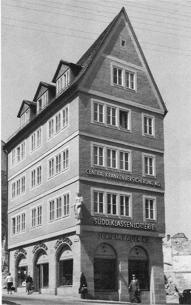
Tradition als Anregung: Kaiserstraße 38. Architekt Wilhelm Schlegtendal, 1949. Aufnahme 1950.
