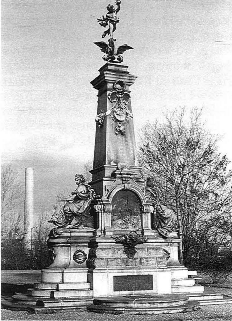
Das amputierte Denkmal im Abseits: Die Brunnenbecken abgeschnitten, die Wasserspeier ohne Funktion. Links hinten der Schlot der größten Nürnberger Kläranlage.
