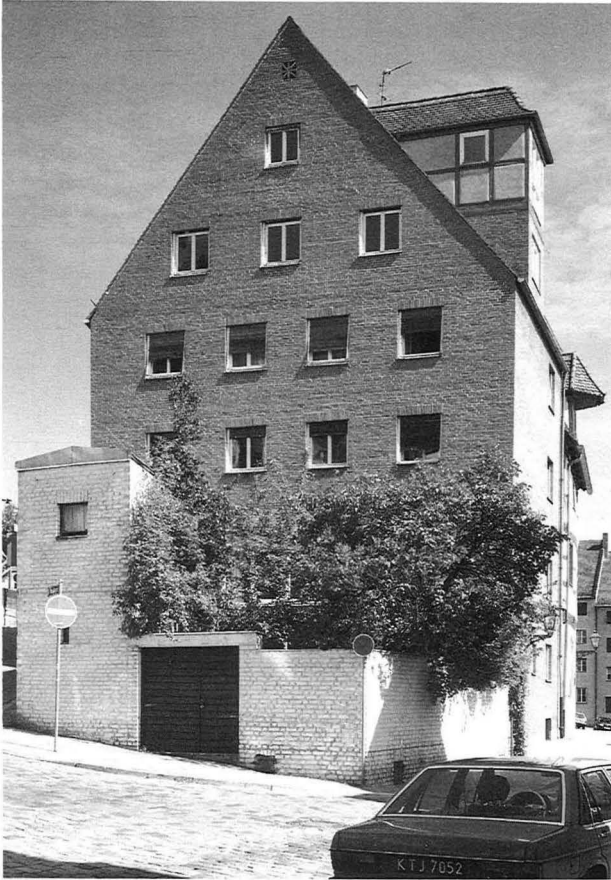
Herausragende Einzelleistung: Ölberg 11 (Architekt Kurt Engelhardt, 1960). Auf- nahme 1991.
