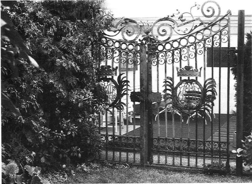
12 Tor-Odyssee: Jetziger Standort Laufamholz. Die Monogramme und Kronen sind wegen Verrostung völlig erneuert.
