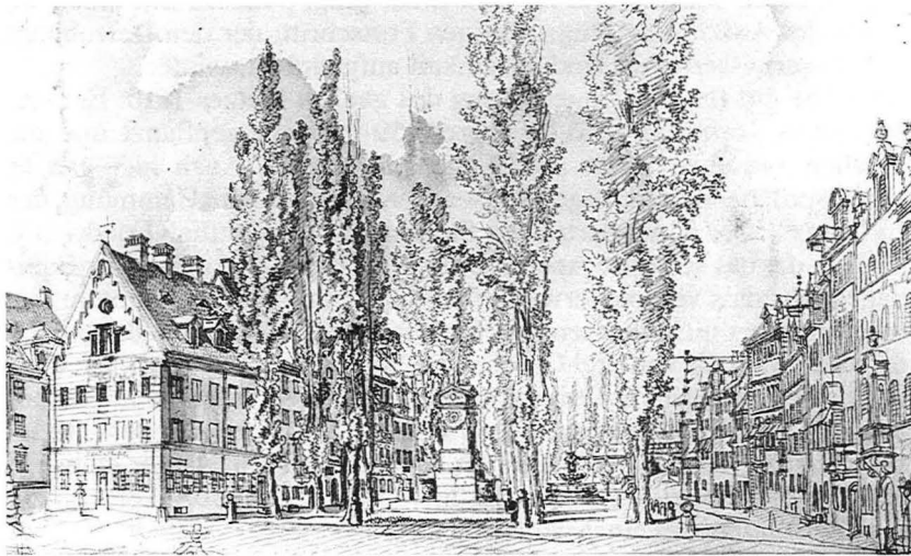
17/18 Vom gepflasterten Stadtplatz des „Neuen Baus“ (Delsenbach um 1720, von Westen gesehen) zur Grünanlage des „Maximiliansplatzes“ (Georg Christoph Wilder 1841, Blick von Osten): Die einstige Dominanz des Brunnens mit seinem breit ausschwingenden Gitter ist völlig verlorengegangen. Auf dem oberen Bild vorne Trockengestelle der Weißgerber, Häutetransport zur Walkmühle und (vielleicht) das Quellenhäuslein.
