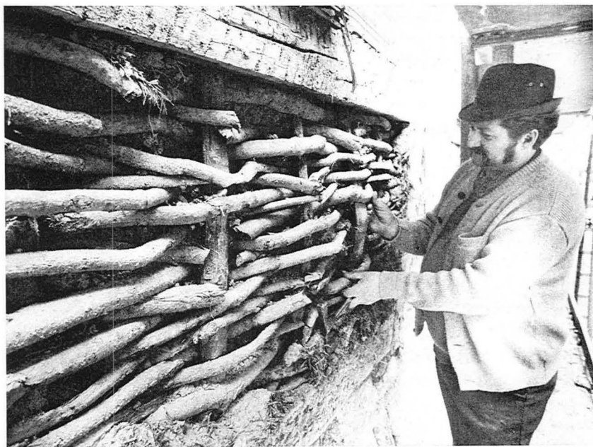
22 Lehmverschmiertes Flechtwerk an der Nordseite des Fachwerkhouses Untere Krämergasse 18. Fast sämtliche Gefache bis zur Giebelspitze waren ähnlich gefüllt — und sind es unter dem neuen Verputz heute noch.
