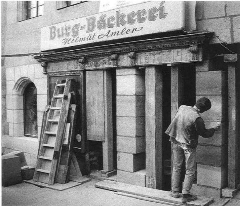
9 *Fachgerechte steinmetzmäßige Auswechslung der schmalen Mauerpfeiler zwischen Türen und Schaufenstern des Erdgeschosses.*
