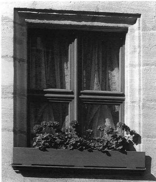
Oberfläche sich zurückhaltend in den Farbton der Sandsteinfassade einfügt. Natürlich gehört zu einem solchen Fenster auch ein sauber eingearbeitetes Fensterblech mit eingewinkelter Tropfnase.
