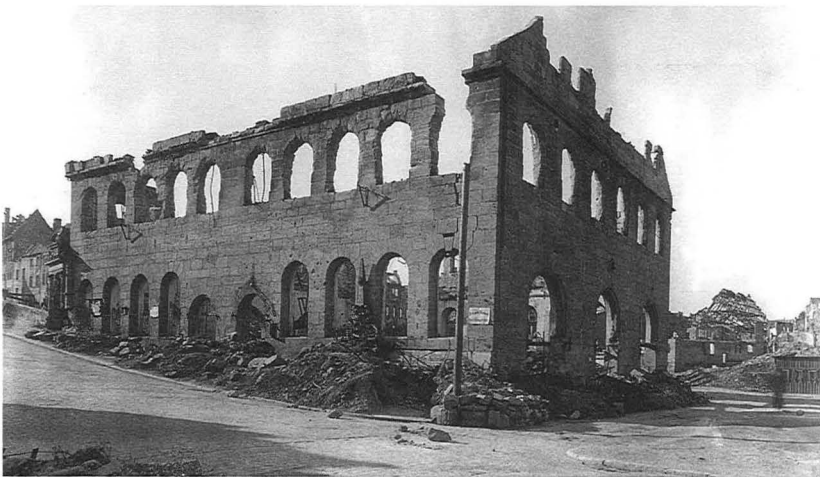
33 Markanter Brückenkopf, Denkmal der Wirtschaftsgeschichte – trotzdem keine Wiederherstellung des Fleischhauses.
