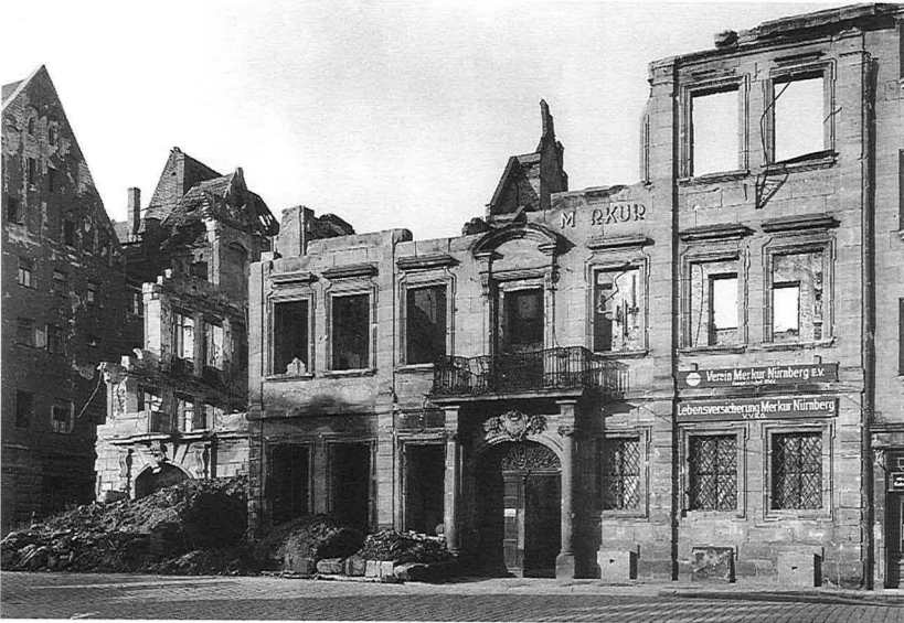
16/17 Ähnlicher Zerstörungsgrad, entgegengesetztes Ergebnis: Adlerstraße 28 (oben) wiederhergestellt, Weinmarkt 10 verloren
