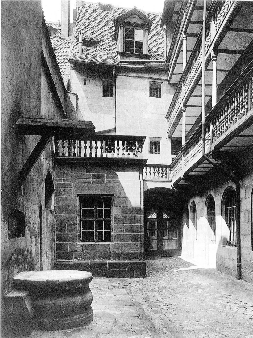
10 So könnte es auch im Hof Winklerstraße 13 einmal ausgesehen haben: Der Wand-Hofbrunnen im Fembohaus mit deutlich erkennbarem Keilsteinring, allerdings ohne Stufe. Heute sind die Sandsteinplatten im linken Hofteil durch Kleinpflaster ersetzt, die Keilsteine aber erhalten.
