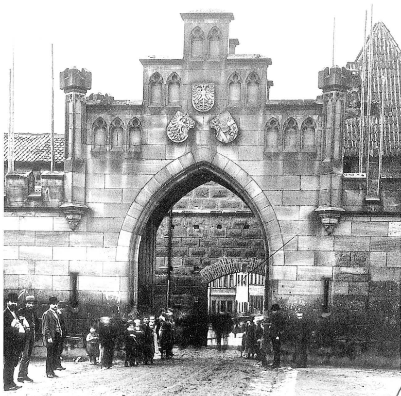
5 Sind die Gerüststangen Vorboten des Abbruchs? Die Brücke ist schon seit 1881 verschwunden und durch einen Damm ersetzt.
