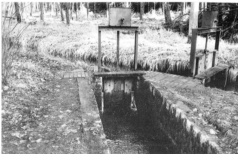
4 Am „steinernen Wehr“: Der Fischbach (im Mittelgrund von links nach rechts) gibt einen Teil seines Wassers (vorne) in Richtung Goldbach ab.
