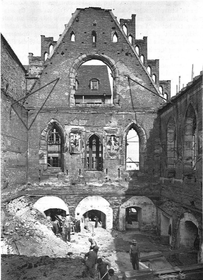
2 Schutträumung in den einstigen Ladengewölben unter dem Saal nach Abbruch der Zwischendecke; Juli 1956. Der Giebel steht noch.
