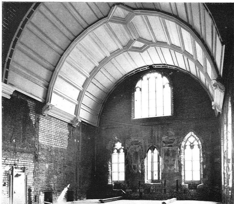
8 Rekonstruiertes Teilstück der Holzdecke; April 1980.
