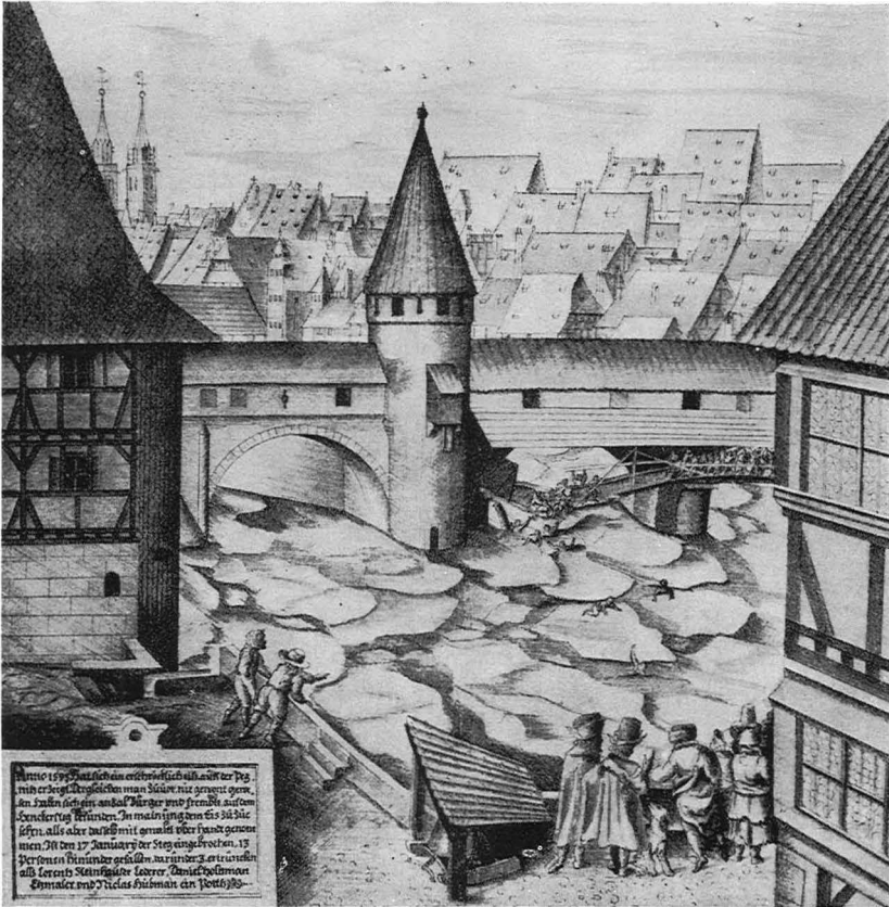
16 Einsturz des alten Henkerstegs am 17. Januar 1595.
