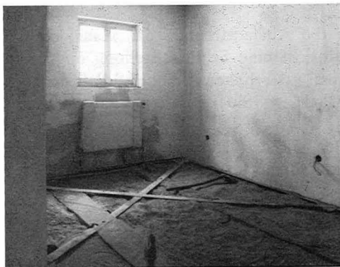
Versteifung der Balkendecken durch randliche Eisenrahmen und diagonale Eisenbänder. Links der „Treppenturm“ als statischer Festpunkt.
