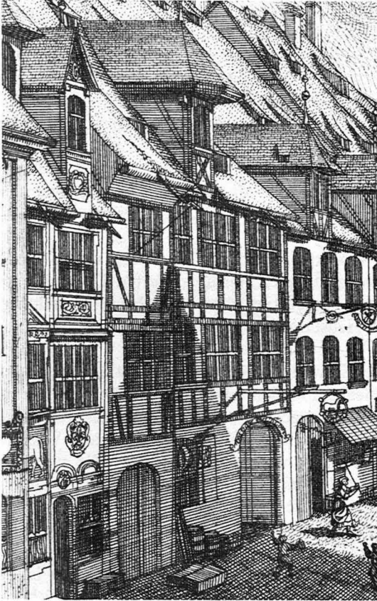
Delsenbach, Äußere Laufer Gasse. Größeres Anwesen mit einfachem Rechteckfachwerk; etwa vergleichbar manchen Handwerker- häusern in der heutigen Weißgerber- gasse.
