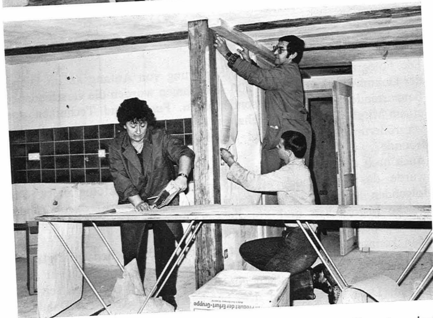
31/32 Endspurt: Von oben bis unten wird das ganze Haus tapeziert
