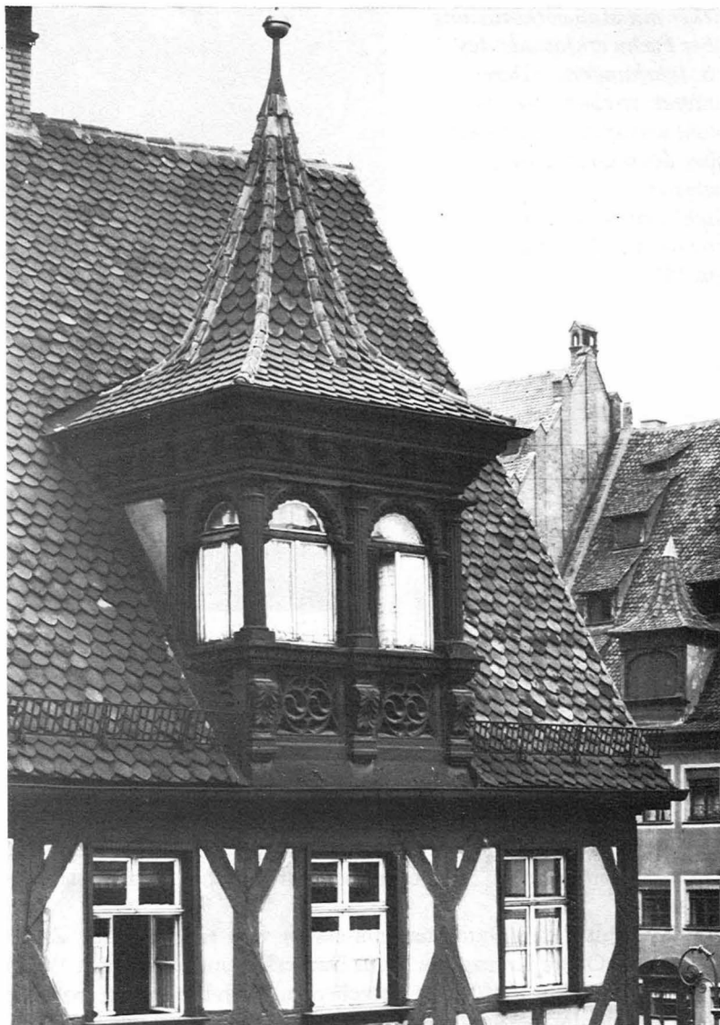
5 Neurenaissance-Erker von 1905 über Fachwerk mit angeblatteten Kopf- und Fußstreben (spätes 15. Jahrhundert) am kriegszerstörten Haus Obstmarkt 1. Man vergleiche das Bild auf Seite 20!
