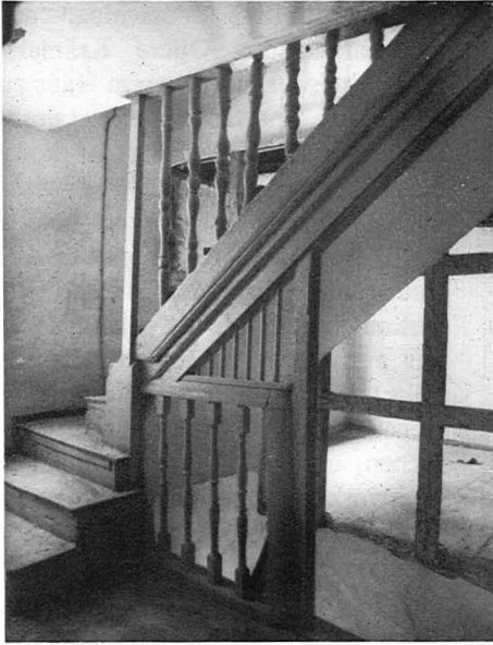
Der ansehnlichste Teil der alten, mehrfach abgewinkelten Treppe (im ersten Obergeschoß)
