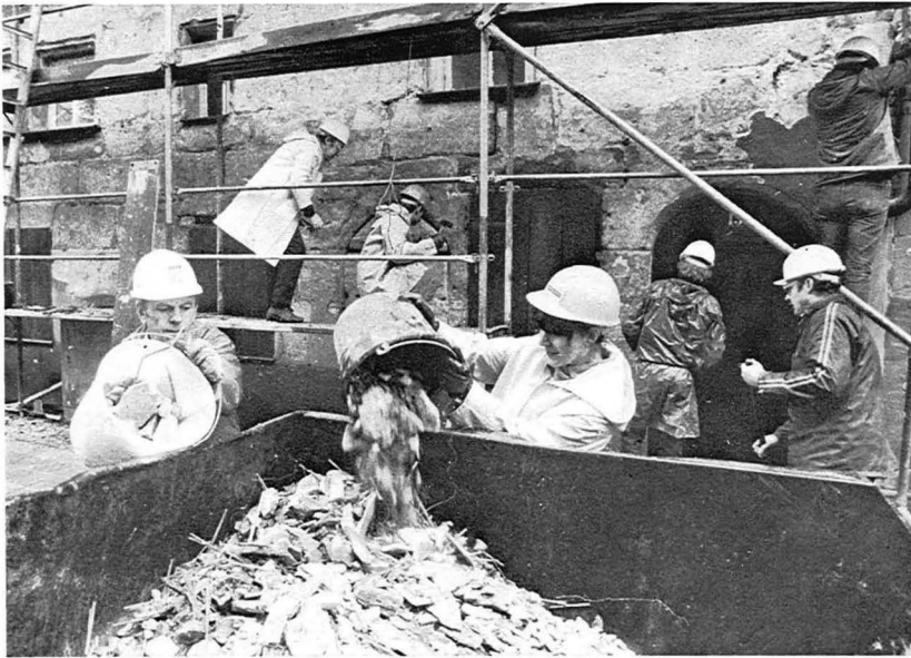
3/4 Der Weg allen Schutts in der Schlehengasse 15: Altstadtfreunde legen erstmals eine Fassade in Samstagarbeit selbst frei
