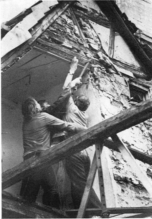
Programmierter Verfall, zupackende Altstadt- freunde: Wetterseite Johannesgasse 55 abgedichtet
