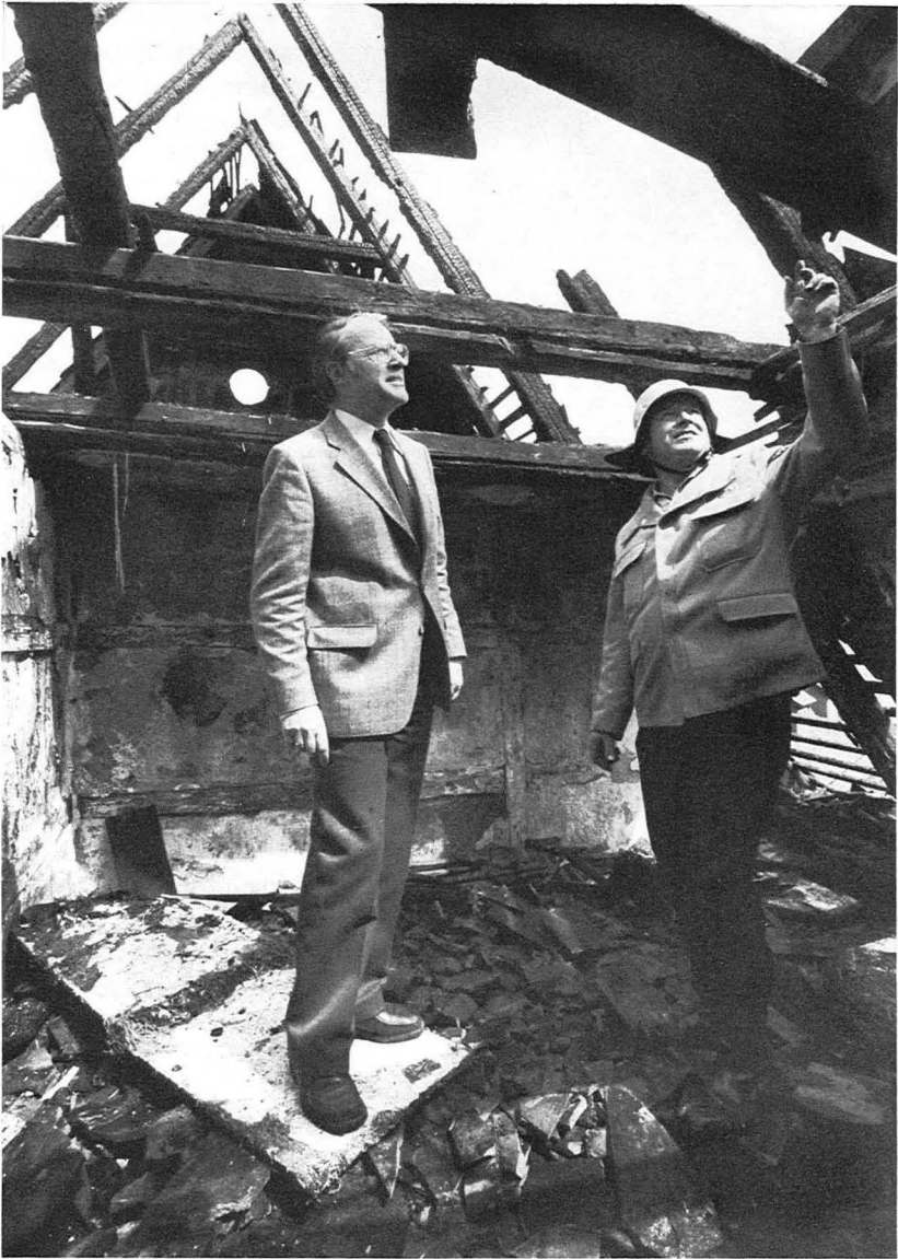
1 Am Morgen nach dem Brand: Kappengasse 16 am Tiefpunkt
